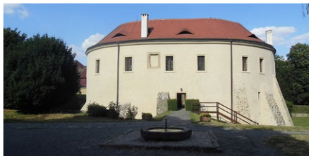
Roztoký zámek – hlavní budova
