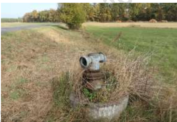
Obr. 16 Příklady hydrantů pro napojení detailního rozvodu závlahy postřikem (foto: VÚV TGM, 2021)
