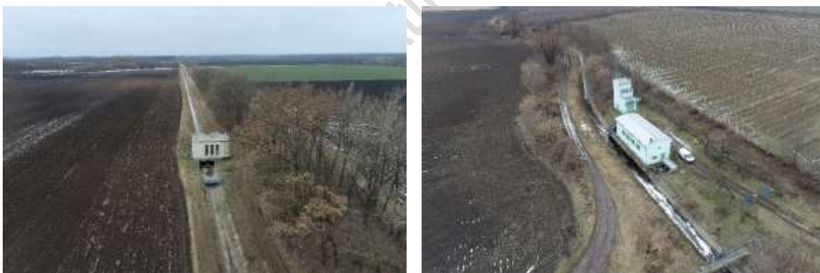
Obr. 18 Krhovice – Hevlín, ukázka čerpacích stanic na závlahovém kanálu, vlevo v Hevlíně, vpravo v Dyjákovcích (foto: VÚV TGM, 2022)
