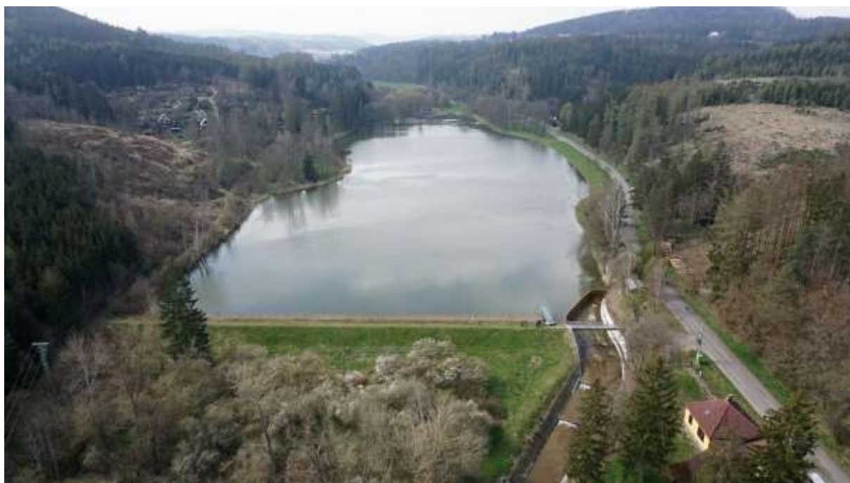
Obr. 4 Malá Haná, lokalita Jevíčko. Vodní nádrž Smolenská – součást bývalé závlahové soustavy „Malá Haná“ vybudovaná pro zajištění dostatečného množství vody pro závlahy v letním období (foto: VÚV TGM, 2021)
