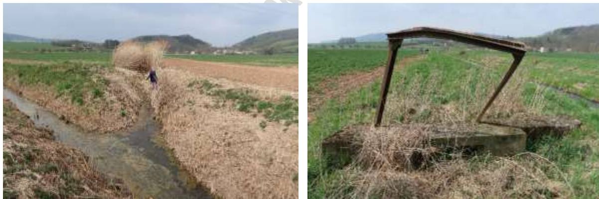
Obr. 3 Malá Haná, lokalita Mezihoří. Vlevo soustava bývalých závlahových kanálů, vpravo relikv stavidel na závlahovém kanálu (foto: VÚV TGM, 2021)
