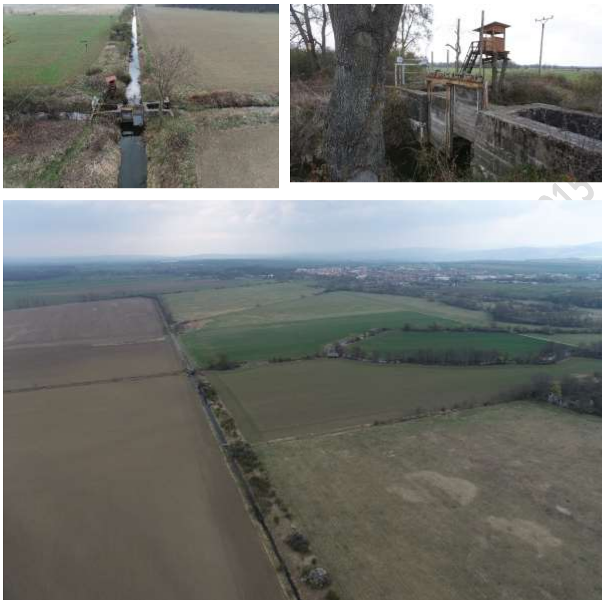
Obr. 5 Pomoraví, lokalita Strážnice-Petrov – soustava závlahových kanálů, ukázka jejich křížení a objektů stavidel (foto: VÚV TGM, 2022)
