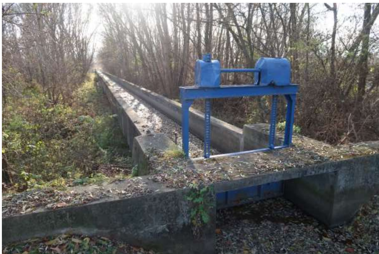
Obr. 19 Krhovice – Hevlín, akvadukt se stavidlovým uzávěrem jako součást závlahového systému (foto: VÚV TGM, 2021)
