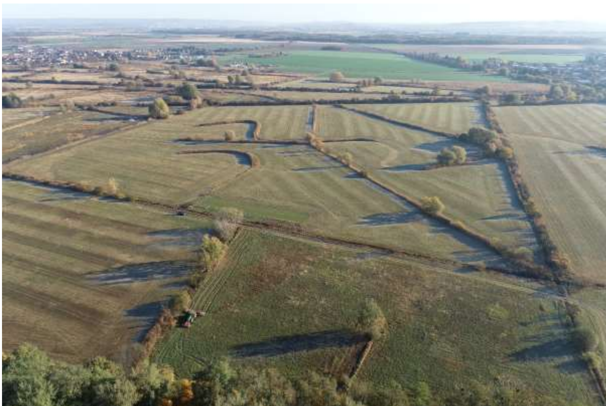
Obr. 6 Pomoraví, lokalita Chropyně – soustava závlahových kanálů a jejich křížení (foto: VÚV TGM, 2021)
