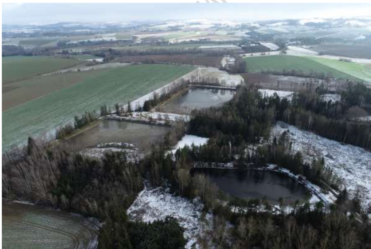
Obr. 22 Šmolovy, soustava tří akumulčních vodních nádrží, do kterých se čerpala 3,2 km dlouhým výtlačným potrubím předčištěná odpadní škrobárenská voda k závlaze zemědělských pozemků (foto: VÚV TGM, 2022)
