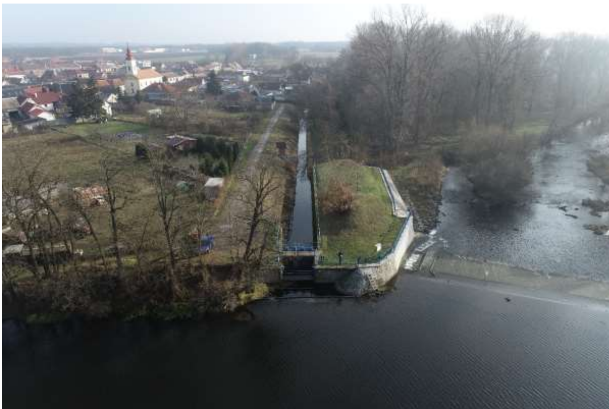
Obr. 17 Krhovice - Hevlín, začátek hlavního kanálu v Krhovicích v levém břehu Dyje, nad krhovickým pevným jezem (foto: VÚV TGM, 2021)
