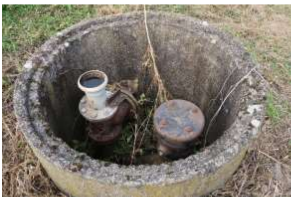
Obr. 16 Příklady hydrantů pro napojení detailního rozvodu závlahy postřikem (foto: VÚV TGM, 2021)
