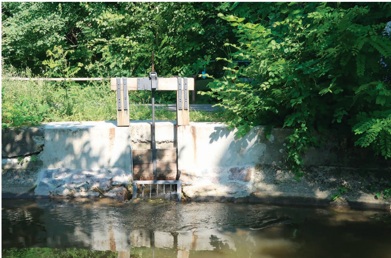
Obr. 9-1 Stavidlo regulující odtok vody z Opatovického kanálu do Kladrubského kanálu (foto Miriam Dzuráková, 2021).
