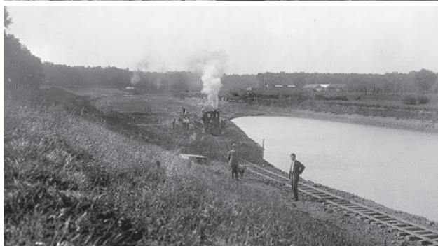
Obr. 5-2A–C Na snímcích z vodohospodářských úprav v Po-moraví z 30. let 20. století je patrné využití korečkového rýpadla a pracovních drážek pro transport zeminy (MěÚ Kunovice, pozůstalost Ing. Lorenze).
