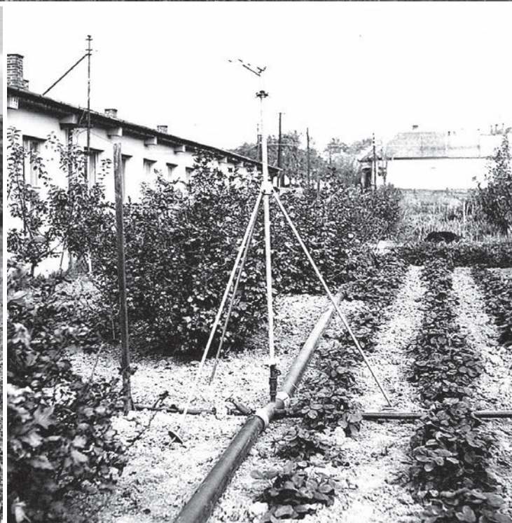
Obr. 5-18A–C Výzkum využití postřikovačů v praxi. A – měření vzdálenosti dostřiku a intenzity postřiku v závislosti na vstupním nastavení (archiv Jana Šálka).
