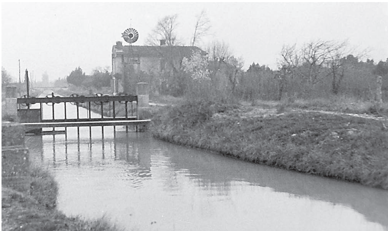
Obr. 5-4 Snímek ilustruje praktické využití větrníku pro čerpání vody ze závlahového kanálu ve Francii, 30. léta 20. století. V popředí můžeme vidět také jeden z příkladů provedení stavidel s více tabulemi (MěÚ Kunovice, pozůstalost Ing. Lorenze).
