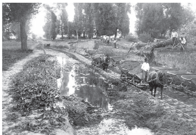
Obr. 5-1A–B Na snímcích z období provádění regulací v oblasti Pomoraví (regulace Moravy, Olšavy, výstavba Baťova kanálu aj. úpravy) je patrný způsob využití koňských potahů a manuální práce při různých činnostech. Podle toho si můžeme udělat představu o způsobech provádění regulací a hydromeliorací na přelomu 19. a 20. století. V době provádění vodohospodářských úprav v Pomoraví, v čase pořízení snímku (20. a zejména 30. léta 20. století), byl kladen důraz na využití lidské síly v co největším měřítku na podporu zaměstnanosti (MěÚ Kunovice, pozůstalost Ing. Lorenze).
