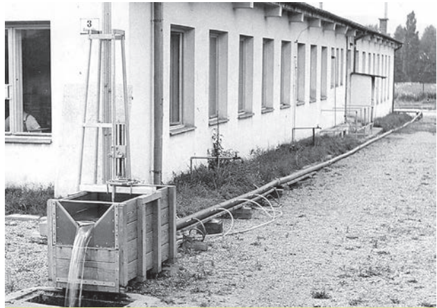
Obr. 3-6 V Československu také probíhal vývoj a zkoušení rychlospojkových potrubí – ukázka z výzkumu VUT v Brně (archiv Jana Šálka, nedatováno).
