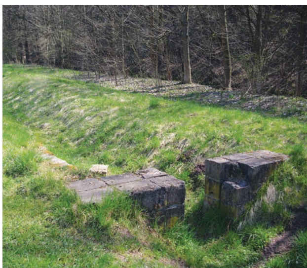
Obr. 3-2 Současný stav regulačního objektu a sběrného kanálu z bývalé hřbetinové závlahy podél Úpy pod zámkem Ratibořice, stav po obnově systému na začátku 90. let 20. století (foto Miloš Rozkošný, 2021).
