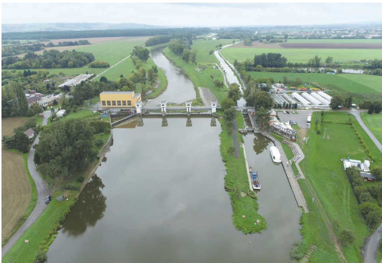
Obr. 2-2 Plavební komora na Baťově kanálu, jez a malá vodní elektrárna na řece Moravě (foto Radek Bachan, 2022).
