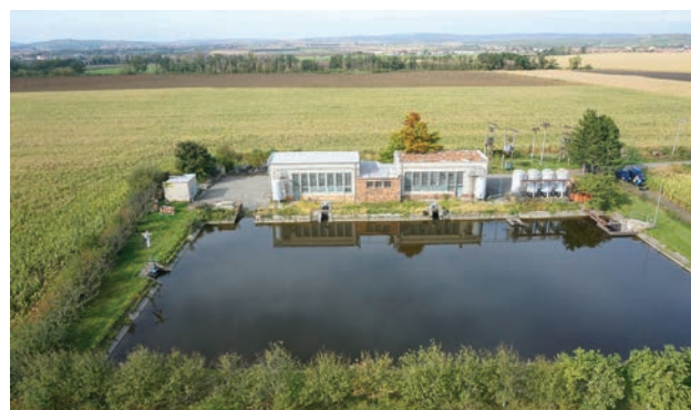
Obr. 1-1 Pohled na jeden z uzlových bodů závlahové soustavy na Břeclavsku a Hodonínsku, období realizace 1972 až 1989, čerpací stanice ČSZ 15, akumulární nádrž (závlahový vodojem), napojená výtlačkem na zdrojovou čerpací stanici u dyjského ramene. Jedinečný doklad funkčního celku v původním architektonickém stavu, doplněný řadou autentického vybavení a náhradních dílů (foto Radek Bachan, 2021).
