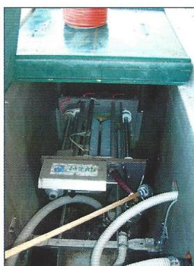
Obr. 3. Mikrosítový filtr
