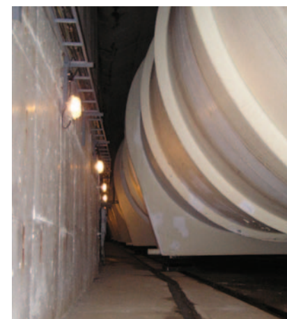
Obr. 4.153: PVE Dalešice – tlakové turbínové ocelové potrubí uložené v chodbě. Foto VUT v Brně, FAST, 2015; schéma Radek Mišanec, 2021 (upraveno dle: Hynková, 1984).
