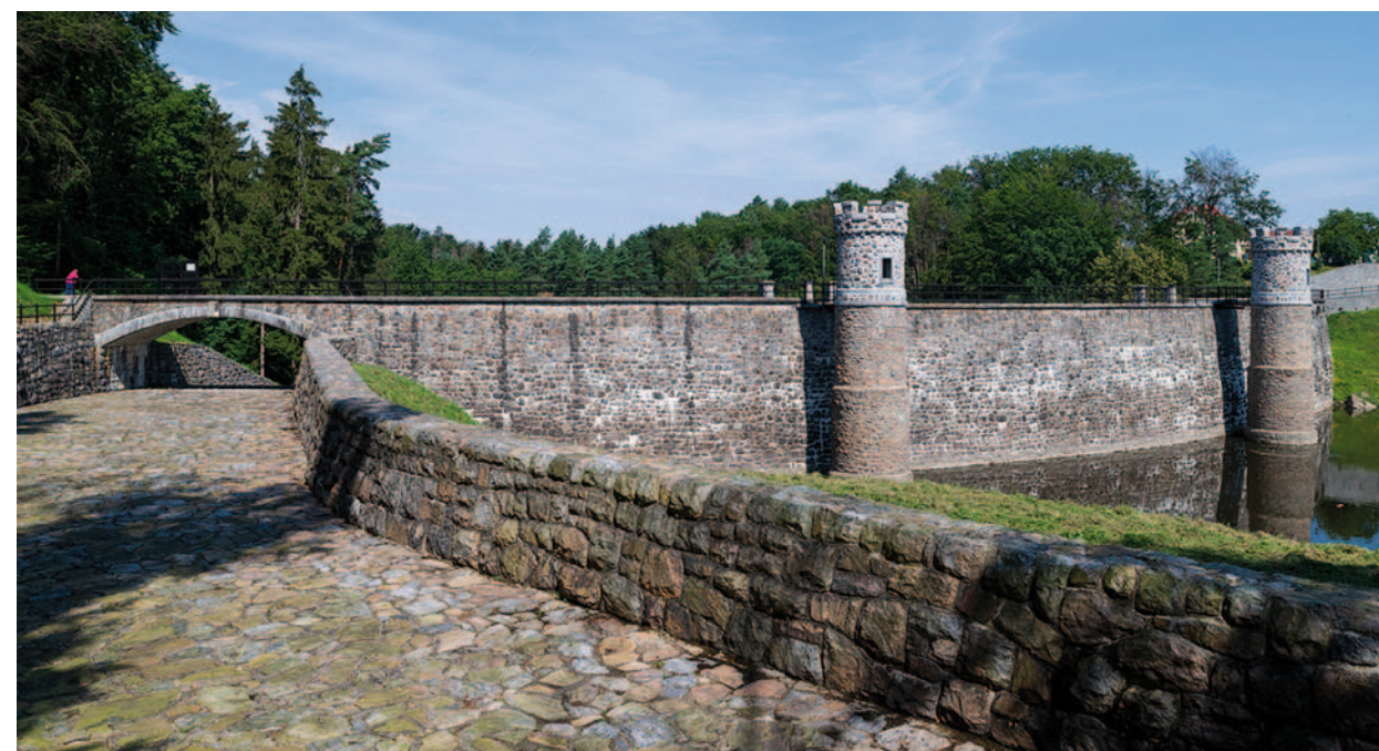
Obr. 4.11: Přehrada Pařížov (1909–1913) – přelivová hrana bočního bezpečnostního přelivu a spadiště, které za mostem navazuje na kaskádu. Foto Viktor Mácha, 2020.
