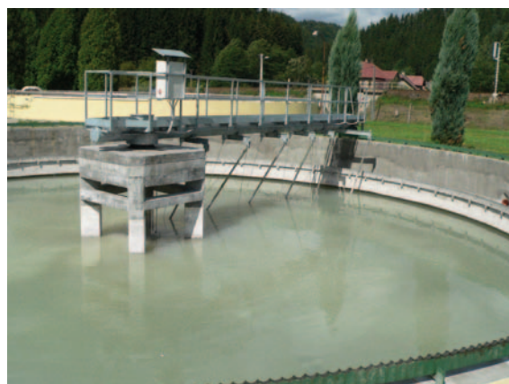
Obr. 4.244: Radiální usazovací nádrž. Foto archiv VÚV.
