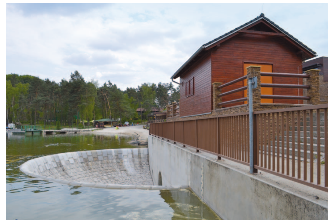
Obr. 4.31: Máchovo jezero (1366) – přímá zemní hráz z místních materiálů, detail kašnového bezpečnostního přelivu. Foto Miroslav Kolka, 2016.
