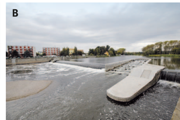
Obr. 4.102: Pevný betonový jez: (A) schéma; (B) Břeclav, jez na Dyji. Schéma Radka Račoch a Radek Bachan, 2021 (upraveno dle: Gabriel a kol., 1989); foto archiv VUT, 2019.
