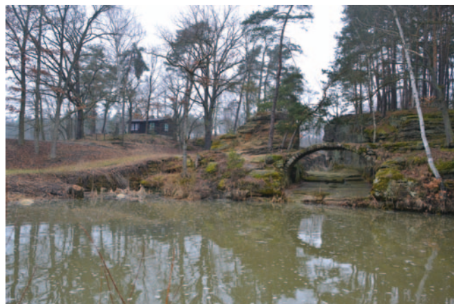
Obr. 4.66: Stvolínky, Mlýnský/Hrázský rybník – hlavní výpust rybníka s mostem, vlevo od ní bezpečnostní přeliv. Foto Miroslav Kolka, 2013.
