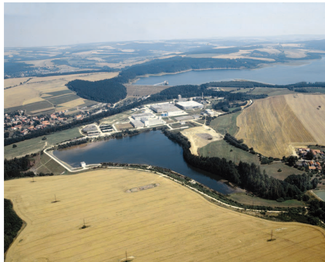
Obr. 4.229: Švihov – letecký pohled na úpravnu vody Želivka. Foto Archiv PVK, f. Fotoarchív PVK, kt. N 17, sign. B 180/00.
