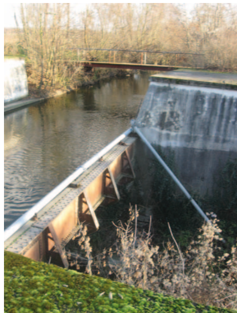
^ Obr. 4.92: Semínský akvadukt na Opatovickém kanále: (A) stav po rekonstrukci; (B) pozůstatky starých dřevěných prvků. Foto David Honek, 2020.
