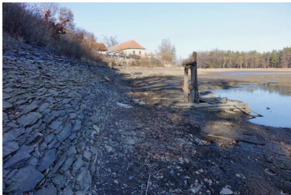
Obr. 4.53: Zbýšou (okres Kutná Hora), Zbýšovský rybník – kamenný taras návodní strany hráze. Foto Jindřich Frajer, 2022.
