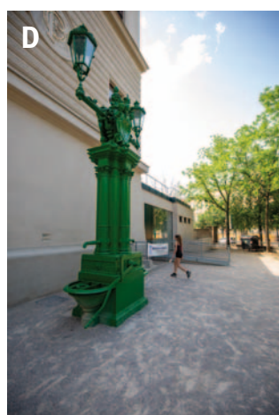
Obr. 5.21: Praha-Letná – věžový vodojem na Letné, konverze: (A) celkový pohled; (B) bezbariérový vstup; (C) knihovna; (D) litinový výtokový stojan s minimalisticky pojatou přístavbou; (E) komín procházející středem vodojemu. Foto archiv NPÚ.
