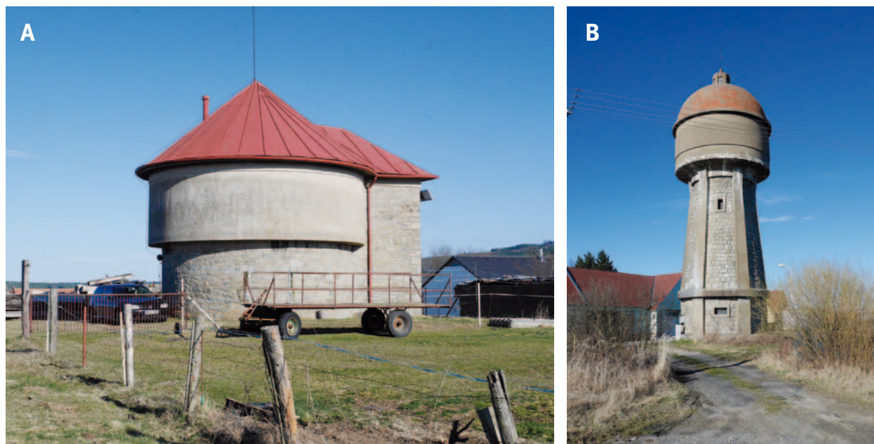
Obr. 4.204: Skupinový vodovod Besednice, Nesměň, Něchov a Todně – jedná se o vodní dílo, vzniklé spojením dvou původně nezávislých vodárenských soustav – vodovod Besednice–Nesměň a vodovod Todně–Něchov. První zmiňovaný vznikl v letech 1922 až 1925 a jednalo se o jednoduchý gravitační vodovod, sestávající z čerpací stanice na svahu Besednické hory, který přiváděl vodu do vodojemu a odtud do místa určení. Druhý vodovod vznikl v letech 1922 až 1924. V letech 1925 až 1928 proběhla stavba samotného skupinového vodovodu, která propojila obě soustavy do jednoho funkčního celku. Vodovodní systém je dodnes funkční, jeho důležitými prvky jsou především čtyři vodojemy, vybudované společně s celou soustavou – jedná se o zemní vodojem, který je součástí čerpací stanice, a věžové vodojemy v obcích Besednice, Nesměň (A) a Něchov (B). Foto Michaela Ryškové, 2022.
