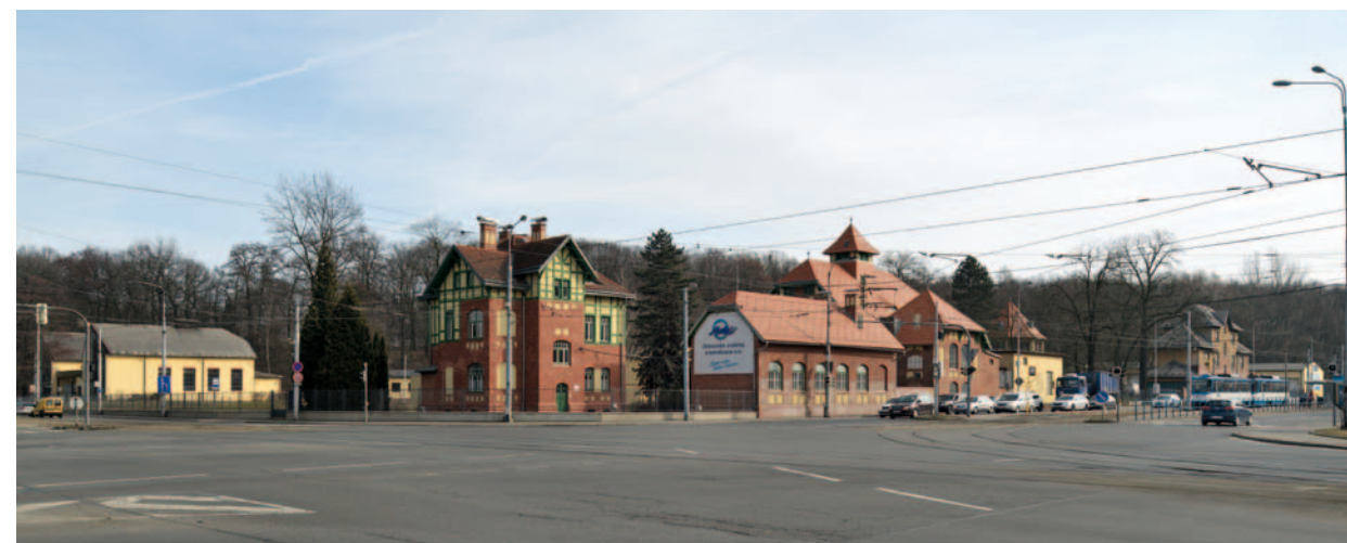
Obr. 5.1: Ostrava – úpravna vody, celkový pohled. Foto Roman Polásek, 2019.
