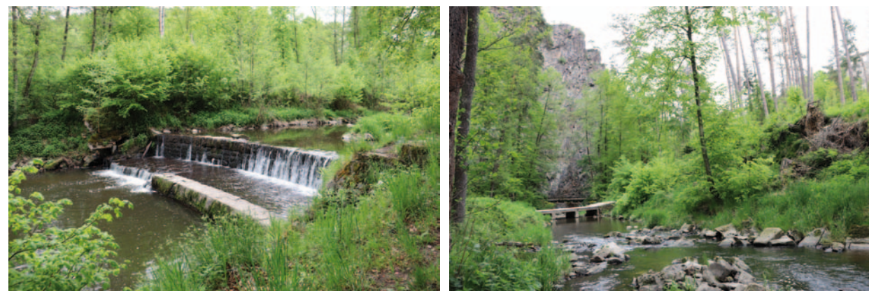
Obr. 5.26: Křemžský potok – vlevo pohled na nejnižší situovaný zachovalý stupeň. Vpravo pohled na jeden z novodobých mostků – betonové prefabrikáty. Foto J. Hansová, 2021.
