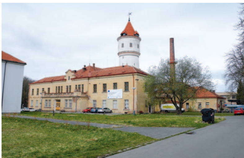
Obr. 4.195: Praha-Bohnice (Psychiatrická léčebna Bohnice) – blok prádelny čp. 25. Rozsáhlý areál psychiatrické léčebny vznikl od roku 1905 do 30. let 20. století. Autor většiny staveb Václav Roštlapil projektoval také věžový vodojem z roku 1908. Studená užitková voda byla čerpána do nádrže v nejvyšším patře, pod ní byly do expanzní nádrže pro regulaci tlaku topné soustavy, níže nádrž na teplou vodu a dole na vodu vlažnou, vedenou do lázní. Studená voda tekla samospádem dolů, kde byla ohřata párou, a sama stoupala do nádrže na teplou vodu, odkud byla rozváděna samospádem do areálu. Vodárna sloužila do roku 1972. Budova původní čerpací stanice byla přebudována na bytovou jednotku. Foto Michaela Ryškové, 2022.
