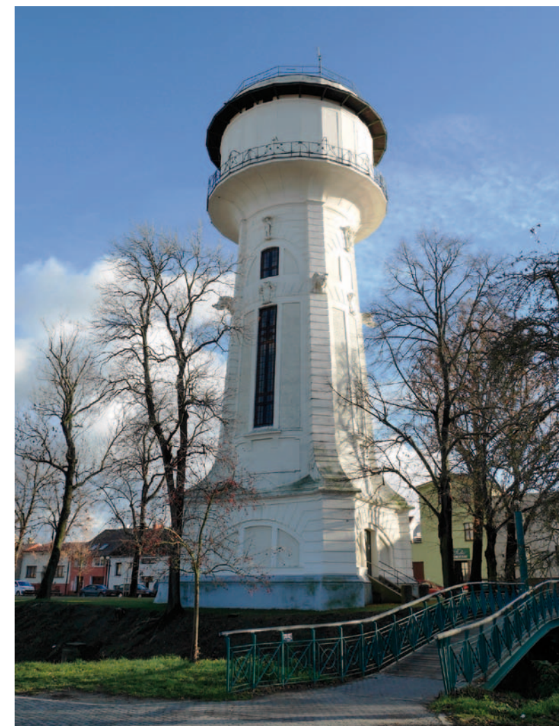
Obr. 3.13: Nymburk – secesní věžová vodojem z roku 1904, projektovaný arch. Osvaldem Políčkou a Ing. Janem Vladimírem Hráským. Foto Michaela Ryškové, 2018.
