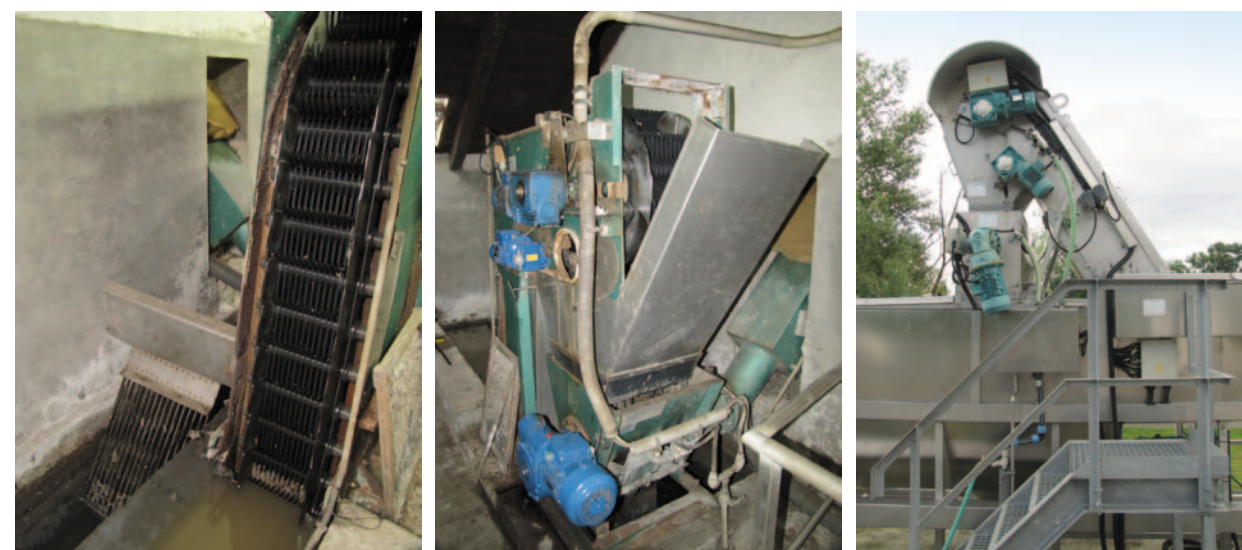
Obr. 4.239: Jemné česle – strojně stírané. Foto archiv VÚV.
