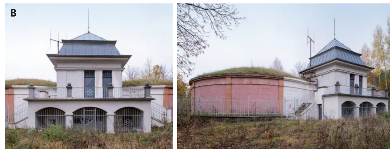
Obr. 4.215: Zemní vodojemy: (A) Olomouc – zemní vodojem na Tabulovém vrchu z roku 1889, vystavěný spolu s 8 km vzdálenou parní čerpací stanicí v Chvoálkovicích; (B) Příbram – zemní vodojem Husa / U Husy, dokončený kolem roku 1930, jímá vodu z dolu Drkolnov. Foto (A) Michaela Ryškové, 2022; (B) Viktor Mácha, 2019.
