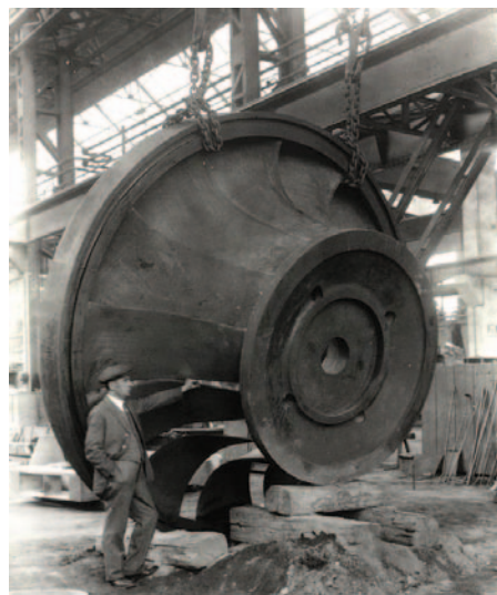
Obr. 4.178: Výroba oběžného kola Francisovy turbíny pro MVE Mířejovice (přezuto z: firemní materiály ČKD Blansko).
