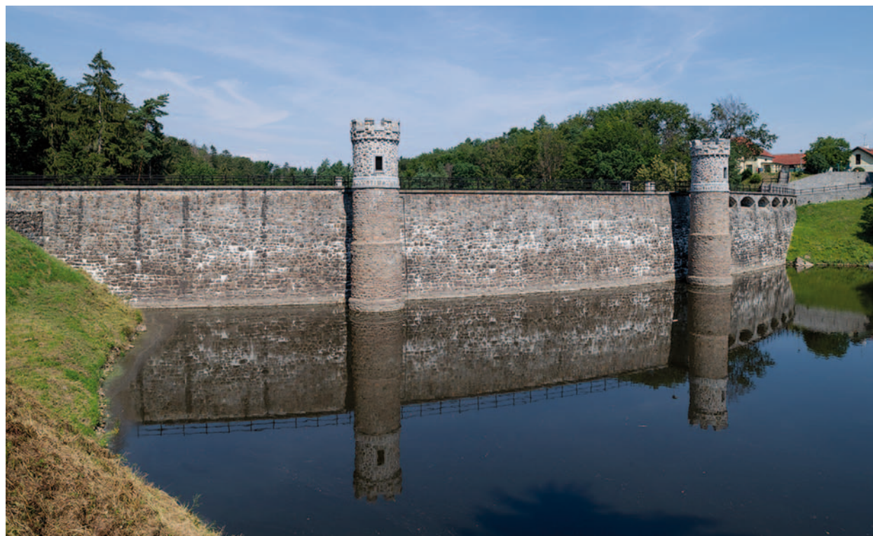
Obr. 4.9: Přehrada Pařížov (1909–1913) – manipulační věže na návodní straně hráze pro ovládání revizních šoupátkových uzávěrů. Foto Viktor Mácha, 2020.
