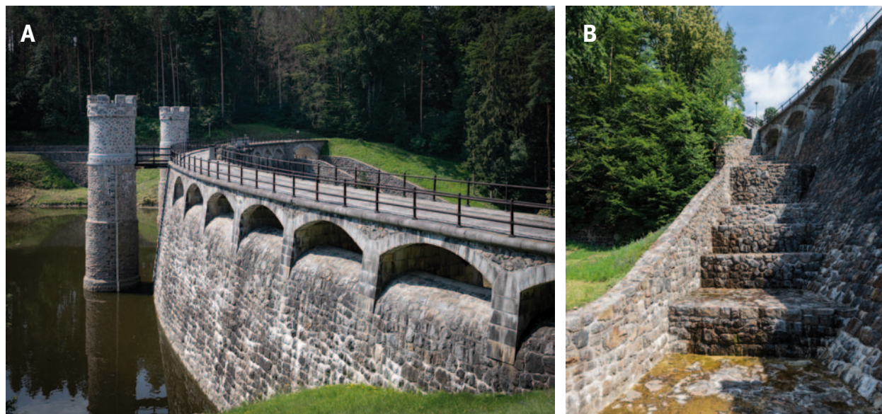
Obr. 4.12: Přehrada Pařížov (1909–1913): (A) pohled na korunový bezpečnostní přeliv z návodní strany; (B) pohled ze vzdušní strany na kaskádu korunového přelivu. Foto Viktor Mácha, 2020.
