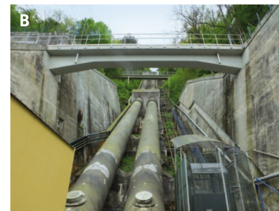
Obr. 4.153: PVE Dalešice – tlakové turbínové ocelové potrubí uložené v chodbě. Foto VUT v Brně, FAST, 2015; schéma Radek Mišanec, 2021 (upraveno dle: Hynková, 1984).
