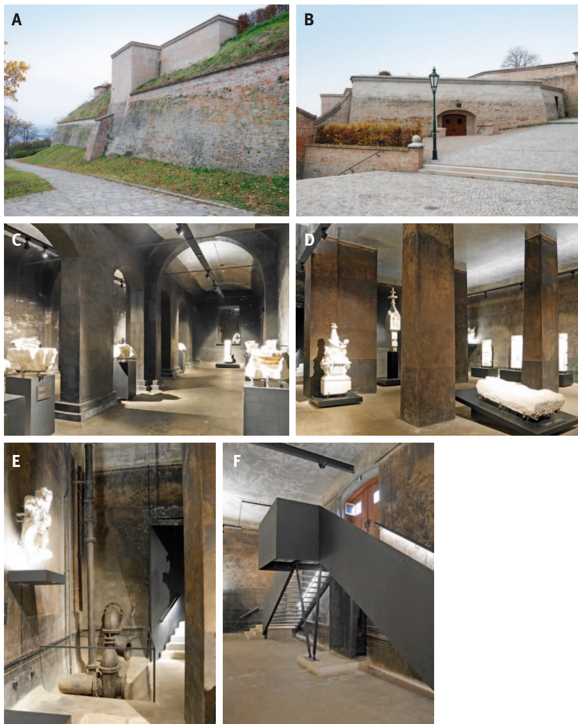
Obr. 5.23: Brno – zemní vodojemy na Špilberku: (A) jihovýchodní bastion hradu Špilberk; (B) nově vybudovaný vstup; (C) lapidárium expozice ve starším vodojemu z let 1870–1871; (D) expozice ve vodojemu z roku 1900; (E) řada původních, dnes již nefunkčních prvků zůstala zachována; (F) nové schodiště. Foto Michaela Ryškové, 2021.
