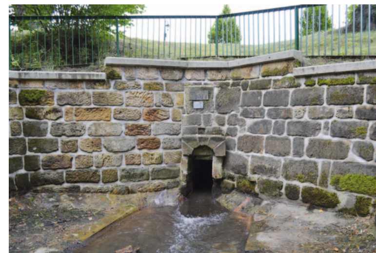
Obr. 4.65: Hamr na Jezeře, Hamerský rybník – vřdušní líc hráže s vyústěním spodní výpusti, datováno 1821, stav po novodobých úpravách zdiva. Foto Miroslav Kolka, 2017.
