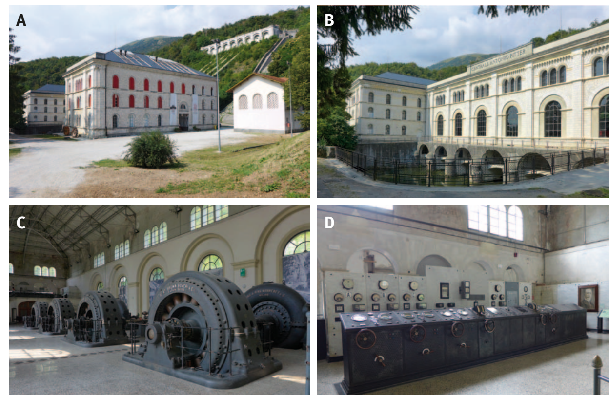
Obr. 5.16: Malnisio di Montereale Valcellina (Itálie) – vodní elektrárna A. Pitter. Foto Michaela Ryškové, 2016.
