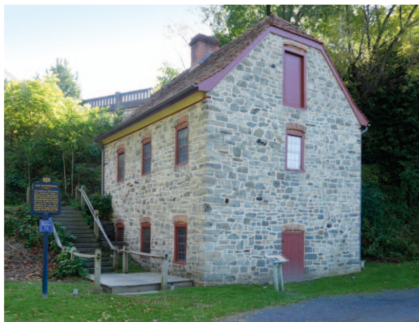
Obr. 3.23: Bethlehem (USA) – čerpací stanice. Evropské raně moderní systémy zásobování vodou 16. a 17. století na principu vzdáleného gravitačního napájení s čerpadly poháněnými vodními koly byly přeneseny do Ameriky. Za nejstarší čerpací stanici vody v USA je považována stanice vybudovaná v roce 1754 pro potřeby městečka Bethlehem, založeného přistěhovanci tzv. Moravské komunity. Voda byla čerpána z pramene do vodárenské věže a odtud proudila gravitačně do pěti cisteren a nádrží. V budově na snímku pracovala čerpací stanice do roku 1832. (Douet, 2018). Foto Michaela Ryškové, 2018.
