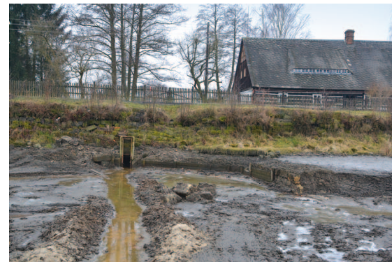
Obr. 4.64: Markvartice u Jablonného v Podještědí, Markvartický rybník – spodní výpust' jalového odtoku s požerákem, návodní líc s typickým opevněním z pískovcových kvádrů, stav po vypuštění rybníka. Foto Miroslav Kolka, 2014.
