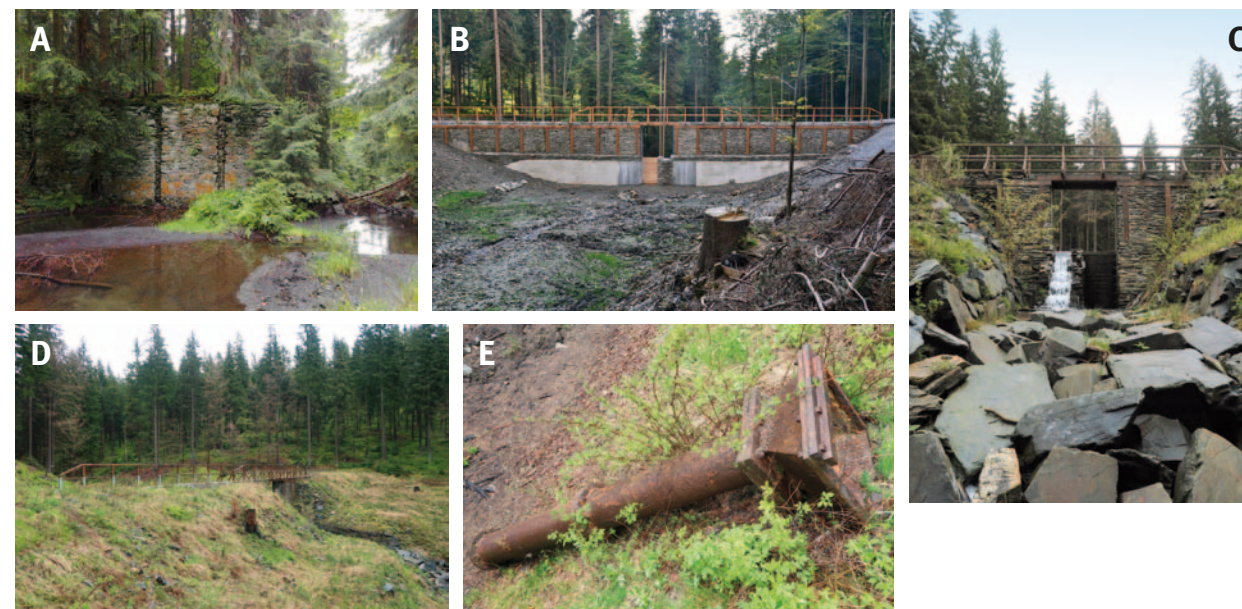
Obr. 5.11: Stará Ves, Žďárský Potok – obnova klauzy na Splavském potoce: (A) zbytky původní hráze; (B) opravená hráze z návodní strany; (C) střední část hráze s průtočnou sekci; (D) celkový pohled na hráze ze vzdušné strany; (E) původní odtokové potrubí. Foto (A) a (B) převzato z: Rymarovsko, 2021; (C), (D) a (E) Martin Caletka, 2021.
