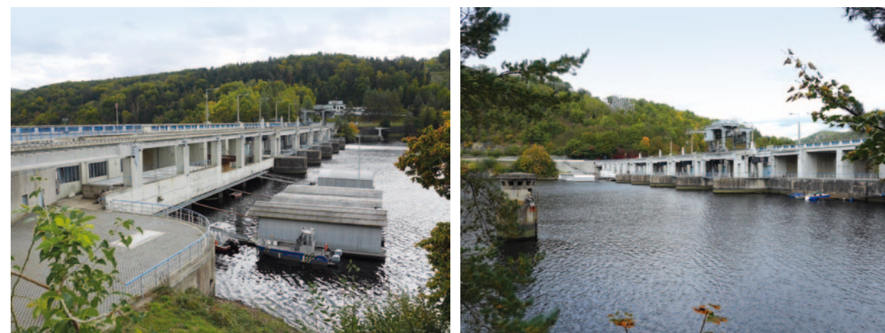
Obr. 4.42: Přehrada Slapy (1949–1957) – tížná betonová přehrada, pohled na návodní líc. Foto Viktor Mácha, 2021 a Michaela Ryšková, 2020.
