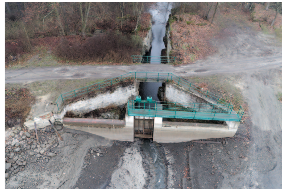
Obr. 4.56: Holany, Holanský rybník – hlavní výpust s odtokem do skalní pískovcové průroy. Foto J. Vidman, 2018.
