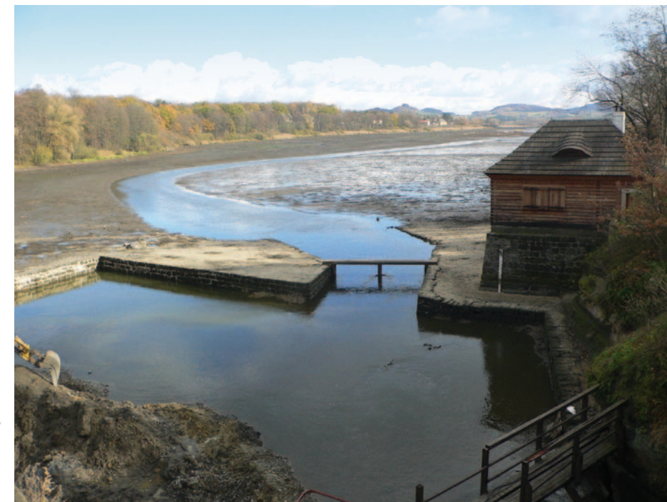
Obr. 4.70: Zahrádky, Novozámecký rybník – loviště s rekonstruovaným rybářským domkem před stavidlovou výpustí z rybníka, ohrazení zdmi z pískovcových kvádrů. Foto Miroslav Kolka, 2006.
