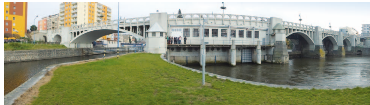
Obr. 4.131: MVE Kolín – pohled z prostoru podjezí na strojovnu a útokovou část MVE (vlevo) a 3 pole válcového jezu (vpravo). Foto VUT v Brně, FAST, 2014.
