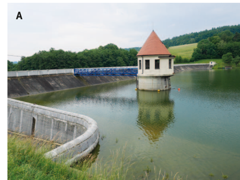
Obr. 4.208: Samostatně stojící sdružené objekty pro odběry vody z nádrží: (A) Přehrada Fryšták – samostatně stojící sdružený objekt úpustí a vodárenských odběrů se strojovou pro ovládání uzávuřů úpustí v horní části. Odběr vody zajišťují dvě potrubí ve dvou úrovních. Součástí vodního díla je také úprava, situovaná pod hrází přehrady. (B) Vodní dílo Švihov – zdroj surové vody pro úpravu vody Želivka. Samostatně stojící sdružený odběrný objekt hráze. Odběr vody je zajištěn dvěma odběrnými pilíři s možností pěti etážových odběrů, sahající až na dno nádrže, zakončenou v koruně nouzovým přepadem. Voda je vedena do čerpací stanice u paty nádrže a dále do úpravy vody (Parkán a Pěkný, 2012). Foto (A) Michaela Ryšková, 2020; (B) Archiv PVK.
