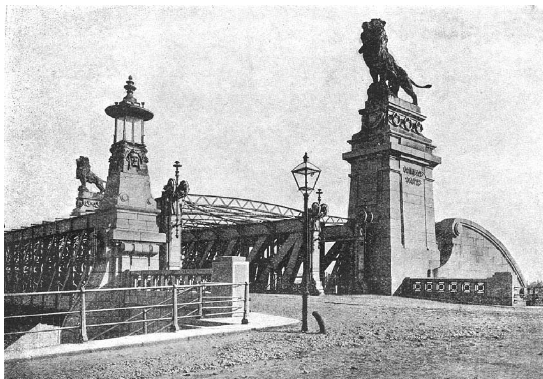
Obr. 3.12: Vídeň-Nussdorf (Rakousko) – most nad zdymadlem. Zdymadlo včetně mostu a provozních budov z let 1894–1899 je po architektonické stránce dílem arch. Otto Wagnera. (přezato z: Wagner, 1910).
