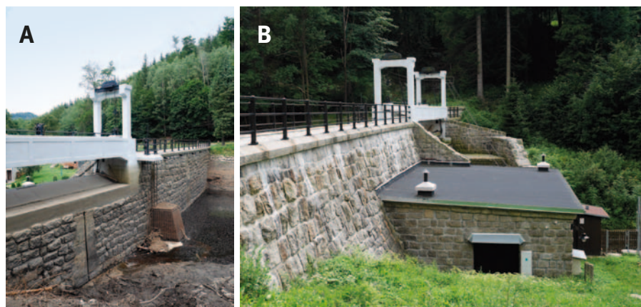
Obr. 4.132: MVE Rudolfov II: (A) návodní líc hráze s otokovým objektem; (B) strojovna MVE. Foto Michaela Ryškové, 2021.
