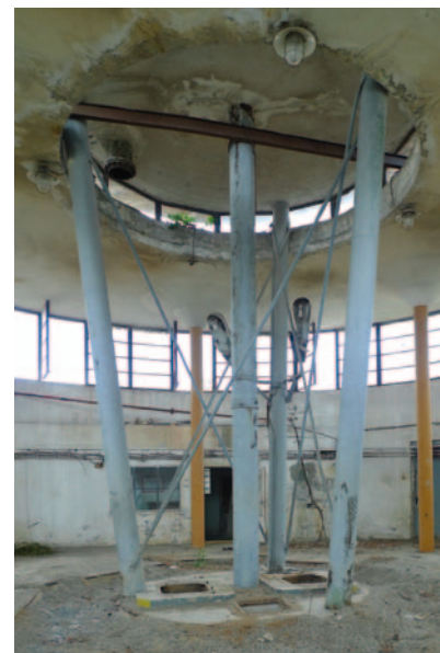
Obr. 4.223: Krnov – věžový vodojem v areálu závodu Karnola. Věžový vodojem neznámé datae a autorství určený pro užitkovou vodu pro textilní závod n. p. Karnola. Vodojem o malé výšce s válcovou nádrží nesenou ocelovými dřívky a architektonicky ztvárněným pláštěm, složeným ze dvou válců různých měřítek a prolomeným dvěma horizontálními pásy oken. Byl zbořen v roce 2020. Foto Michaela Ryškové, 2013.
