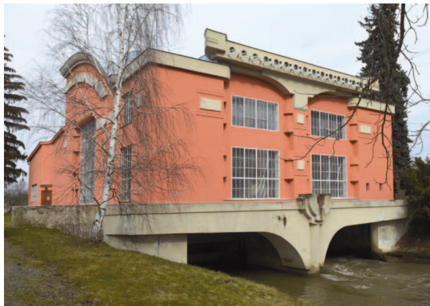
Obr. 3.15: Třeština – vodní elektrárna Háj z let 1922–1923 je dílem arch. Bohuslava Fuchse a Josefa Štěpánka. Do architektonické formy průčelí je přenesena symbolika zrození energie z vodní síly, její koncentrace a transformace. Foto Miloš Matěj, 2016.
