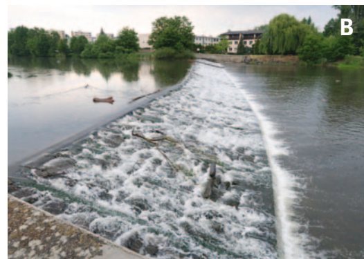
Obr. 4.100: Kamenný jez: (A) schéma; (B) Znojmo-Oblekovice, jez na Dyji. Schéma Radek Míšanec, 2021 (upraveno dle: Gabriel a kol., 1989); foto Miriam Dzuráková, 2022.
