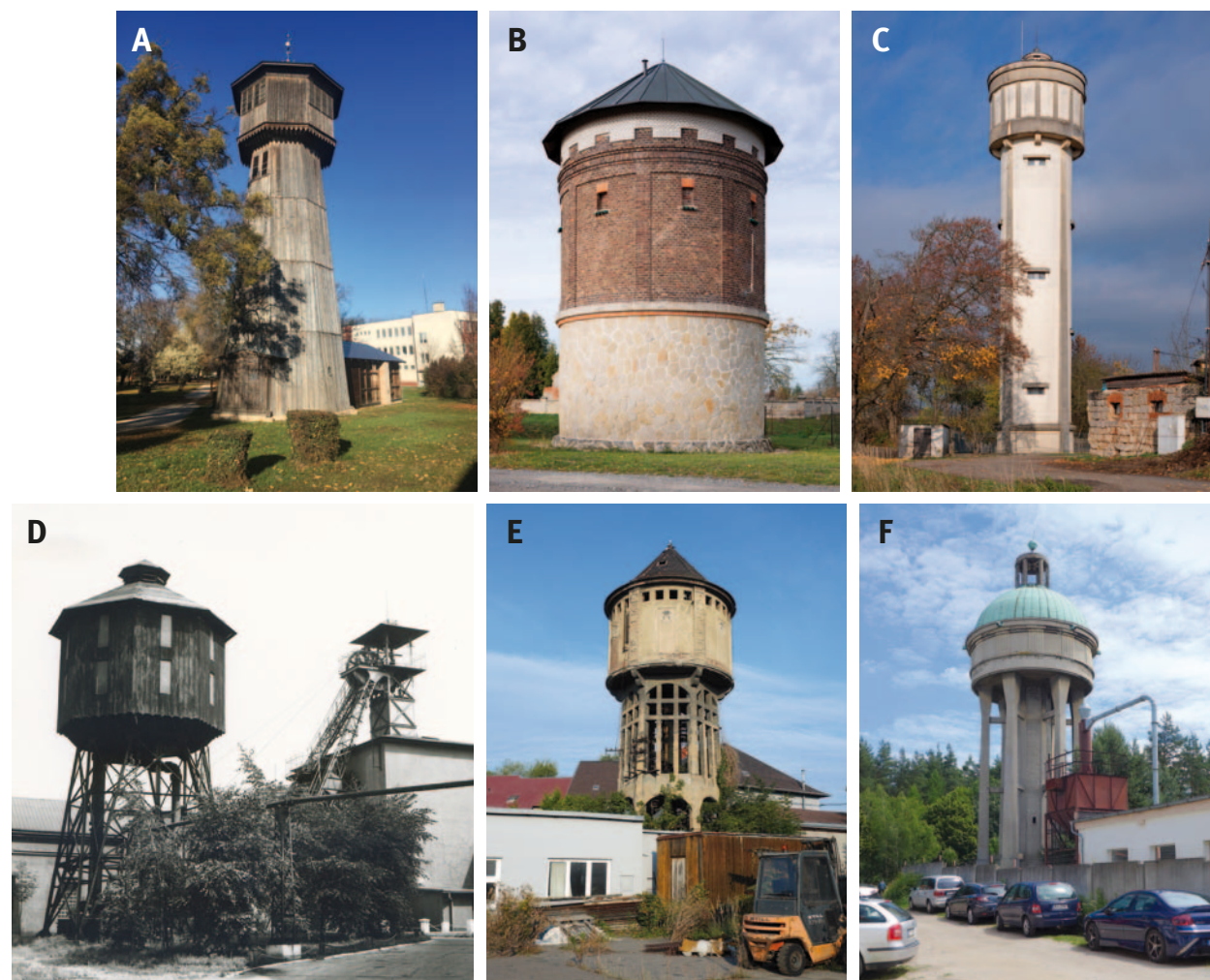
Obr. 4.217: Příklady nosných konstrukcí věžových vodojemů: (A) Palárikovo (Slovensko), dřevěný věžový vodojem, zřejmě jediný zachovalý v Evropě; (B) Kovanec, věžový vodojem se stěnovou nosnou konstrukcí zděnou z kamene a cihelného zdiva, postavený v historizujícím tovaroslouví podle návrhu Karla Kresse v roce 1909; (C) Horní Bukovina, věžový vodojem se železobetonovou nosnou konstrukcí postavený roku 1935 podle návrhu Ing. Fanty; (D) Ostrava, důl Hubert, zaniklý věžový vodojem s ocelovou nosnou skeletovou (příhradovou) konstrukcí a dřevěným opláštěním nádrže na snímku z konce 60. let 20. století; (E) Duchcov, věžový vodojem se skeletovou železobetonovou nosnou konstrukcí postavený v letech 1908–1912 pro sklárnu Engels; (F) Lázně Bohdaneč, věžový vodojem nesený železobetonovou kombinovanou konstrukcí, postavený podle návrhu Josefa Gočára v roce 1911; ve středním dílku je umístěno schodiště. Foto (A), (E) a (F) Michaela Ryškové, 2021, 2020 a 2016; (B) a (C) Viktor Mácha, 2018; (D) archiv NPÚ, MCPD.
