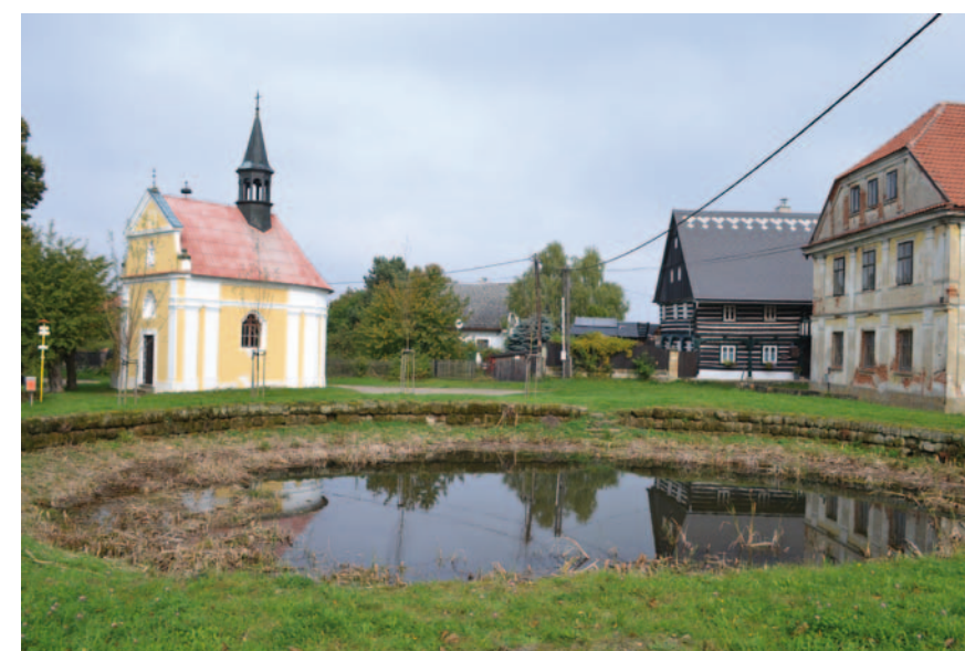
Obr. 4.46: Dražejov – nádrž uprostřed na nási, napájená dešťovými srážkami a přepadem z místního historického vodovodu. Foto Miroslav Kolka, 2014.
