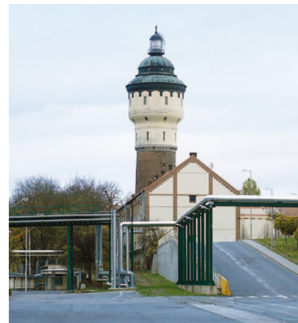
Obr. 4.196: Plzeň – věžový vodojem v areálu pivovaru Prazdroj z let 1905–1907 byl součástí vodovodu Měšťanského pivovaru. Prováděcí projekt zpracoval ing. Spalek a stavitel Hucl. Doželezné nádrže byly usazeny nad sebou, jedna na pramenitou a druhá na říční vodu. Systém vodárny sestával vedle věžového vodojemu z elektrárny pohánějící říční čerpací stanici, objektu hrubého filtru, odželezovací stanice a pračky písku a vodárenské budovy u studny na Roudné. Foto Alena Boroucová, 2020.
