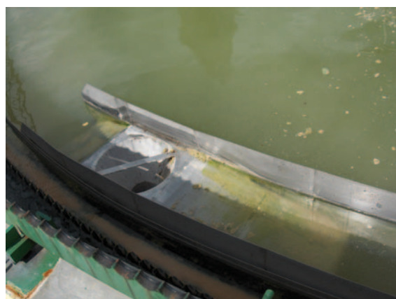
Obr. 4.245: Přelivná hrana. Foto archiv VÚV.
