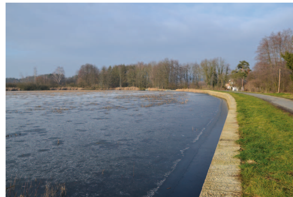
Obr. 4.51: Holany, Holanský rybník – vydutý tvar hráze s obnovou návodní zdi z pískovcových kvádrů. Foto Miroslav Kolka, 2018.
