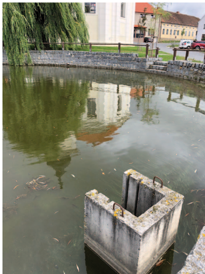
Obr. 4.62: Zbýšov (okres Kutná Hora) – spodní výpust' zaniklého Nového rybníka s dochovanými relikty podtrubní jámy a vývaru. Foto Jindřich Frajer, 2020.
