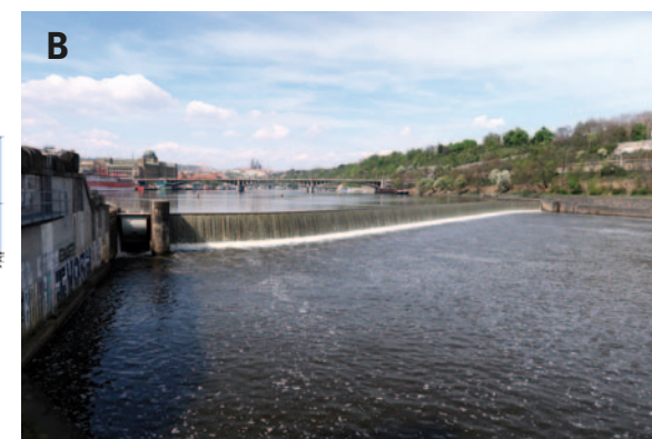
Obr. 4.101: Zděný jez: (A) schéma; (B) Praha, Helmovský jez na Vltavě. Schéma Radka Račoch a Radek Bachan, 2021 (upraveno dle: Průcha, 1980); foto Miriam Dzuráková, 2022.
