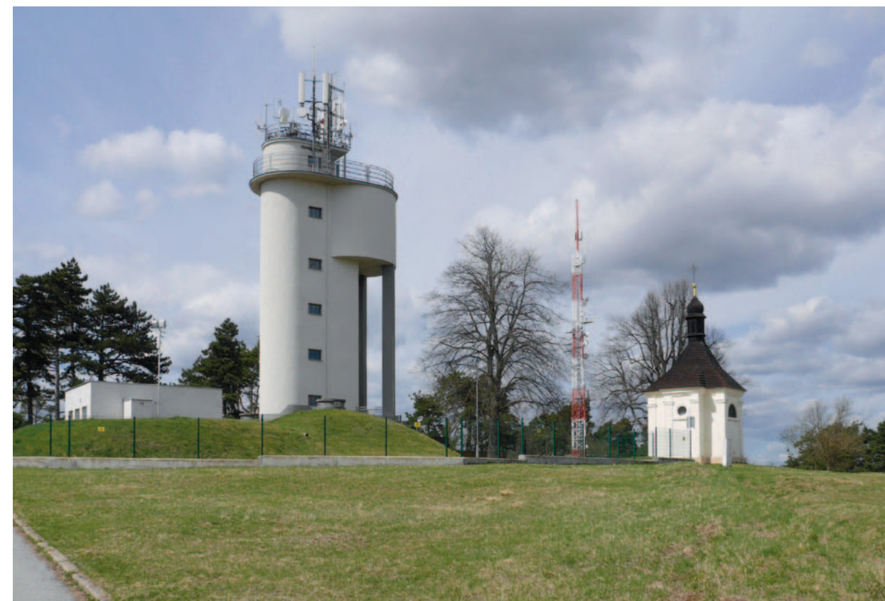
Obr. 5.24: Třebíč – věžový vodojem Kostelíček. Foto Michaela Ryškové, 2022.
