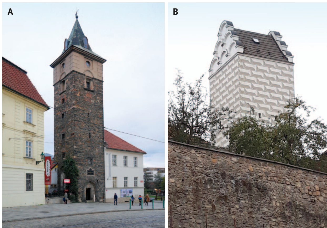
Obr. 3.9: Vodárenské věže: (A) Plzeň, pozdně gotický věžový vodojem z kamenného zdiva, zmiňovaný poprvé roku 1532. Klasicistní objekt čerpací stanice (upravo) byl postaven z kamene ze zbořeně Pražské brány. Gotizující tvar střechy věže pochází zřejmě z roku 1845, kdy byla zvýšena při přestavbě provedené stavitelem Kristiánem Lexou. V roce 1843 byla v nejvyšším patře měděná nádrž o objemu 2,7 m 3 . Čerpací stanice byla vybaena okovaným vodním kolem a tříválcovou pumpou a čerpala vodu z řeky. Vstupní portál osazený v 19. století pochází z městského domu (Hlušíčková 2003). (B) Tábor, renesanční podoba věže se sgrafitovými psaníčky a obloučkovými štíty vznikla po požáru v roce 1559. Město zásobovala údolní nádrž Jordán (z roku 1492), pod jejíž hrází stála čerpací stanice s dřevěným čerpadlem poháněným vodním kolem, které vytlačovalo vodu potrubím do věže zásobující městské kašny (Vávra 1913). Dnes je v objektu galerie. Foto (A) Alena Borovcová, 2020; (B) Eva Dvořáková.
