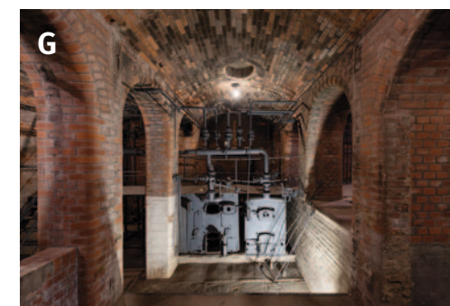
Obr. 4.269: Praha-Bubeneč – Stará čistírna odpadních vod: (D) celkový pohled; (E) stavidloou uzávěr na stoce; (F) lapák písku; (G) kotelna a uhelna pro výrobu teplé vody a vytápění (původně prostor nádrží na vápennou vodu); (H) česle. Foto Viktor Mácha, 2019.
