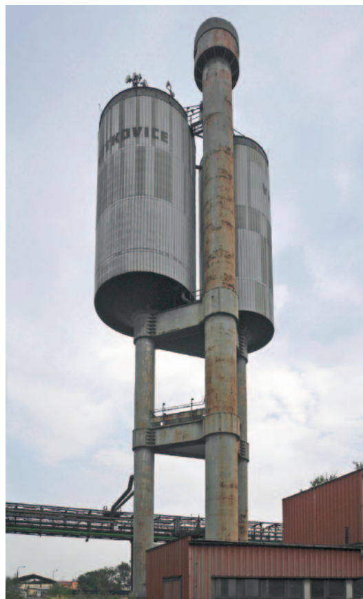
Obr. 4.222: Ostrava-Vitkovice – ocelový věžový vodojem se dvěma nádržemi, vystavěný jako součást průmyslového areálu. Typologicky, konstrukčně i parametricky se vymykal dobové produkci. Konstrukční pojetí bylo odlišné od běžně budovaných ocelových věžových vodojemů z produkce Vítkovických železáren (např. vodojemů v Ostravě-Hladnově). Unikátní bylo nesení každé nádrže samostatným dřívkem a výtahová šachtice umístěná ve třetím, samostatném dřívku, což je doloženo v ČR pouze ve třech případech. Zároveň šlo o jeden z věžových vodojemů s největším objemem v ČR. Ve 3. celostátní soutěži ČSVTS o nejlepší stavbu s nosnou ocelovou konstrukcí získal za rok 1983 hlavní cenu v kategorii Technologické konstrukce. Projektovou a předvýrobní přípravu zajistil Hutní projekt Praha, závod Ostrava (generálním projektantem byl Ing. Ant. Kozák) a VŽKG, k. p., Ostrava (nádobu projektoval Pavel Klimeš) (Devátý, 1983, Soušek, 1982). Vodojem byl zároveň pohledovou dominantou a významným orientačním bodem Vítkovic. Byl zbořen v roce 2022. Foto Michaela Ryškové, 2016.
