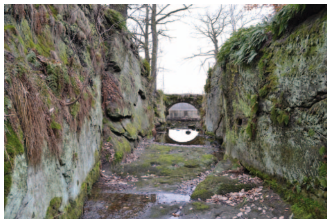
Obr. 4.67: Stvolínky, Dolanský rybník – skalní průřva bezpečnostního přelivu, v pozadí most v trase hráze. Foto Miroslav Kolka, 2016.
