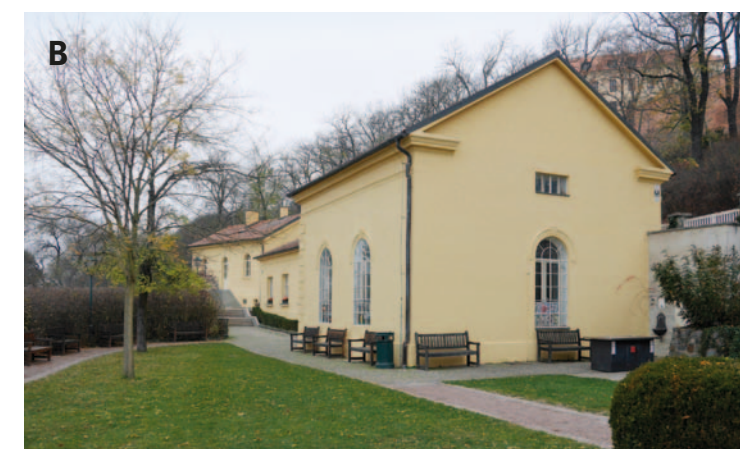
Obr. 3.10: Parní čerpací stanice v Opavě (A) a Brně (B) nesou architektonické formy charakteristické pro tento typ objektů. Jedná se o přízemní stavby se sedlovou střechou a zaklenutými okny. Foto (A) Alena Borovcová; (B) Michaela Ryšková, 2021.
