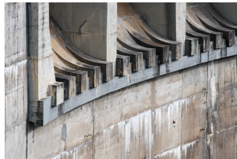
Obr. 3.16: Přehrada Vrchlice (1966–1970) – rytmizovaný detail rozrážeců vody korunového přelivu kontrastuje s monumentální plochou vzdušného líce betonové hráze. Foto Viktor Mácha, 2020.
