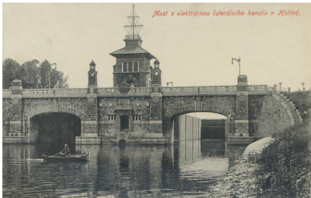
Obr. 3.11: Hořín – zdymadlo laterálního kanálu Vraňany–Hořín, postavené podle návrhu arch. Františka Sandera. Dobová pohlednice, sbírka Michaely Ryškové.
