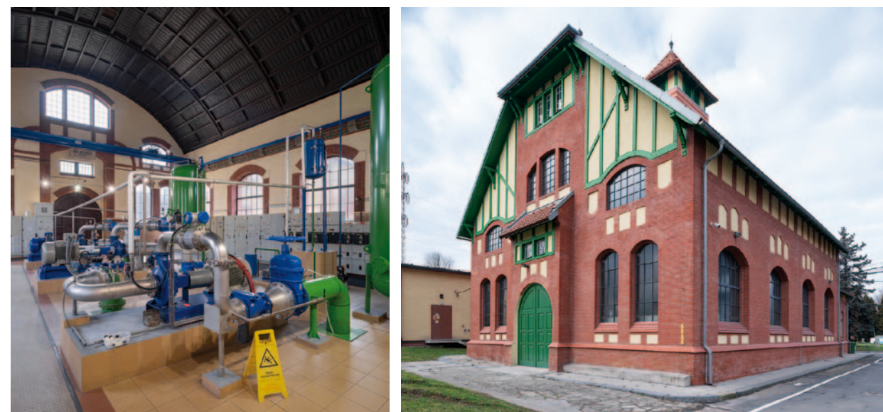
Obr. 5.2: Ostrava – úpravna vody, strojovna. Foto Viktor Mácha, 2019.
