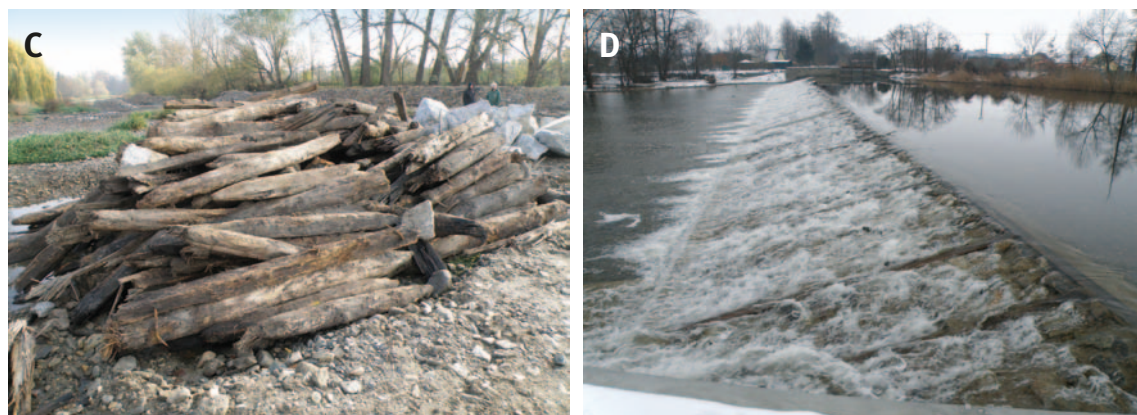
Obr. 5.5: Znojmo-Oblekovicce – rekonstrukce jezu v Oblekovicích na řece Duji: (C) původní části dřevěné trámové konstrukce; (D) rekonstrukce dokončena, leden 2019. Foto Miriam Dzuráková, 2018–2019.
