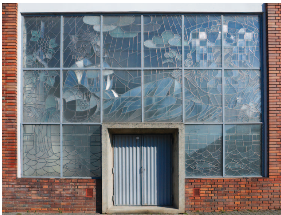
Obr. 3.19: Znojmo – zemní vodojem se dvěma železobetonovými kruhovými nádržemi byl postaven v letech 1949–1950 podle návrhu Vítězslava Lorenze. Pro okno v uličním průčelí byla zhotovena vitráž Alegorie řeky Dyje z různě strukturovaného skla provedená podle návrhu Vojtěcha Kubašty roku 1950 (Stará, 2007). Foto Michaela Ryškové, 2020.
