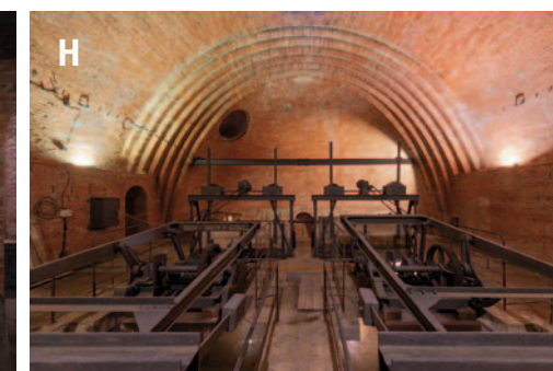
Obr. 4.269: Praha-Bubeneč – Stará čistírna odpadních vod: (D) celkový pohled; (E) stavidloou uzávěr na stoce; (F) lapák písku; (G) kotelna a uhelna pro výrobu teplé vody a vytápění (původně prostor nádrží na vápennou vodu); (H) česle. Foto Viktor Mácha, 2019.
