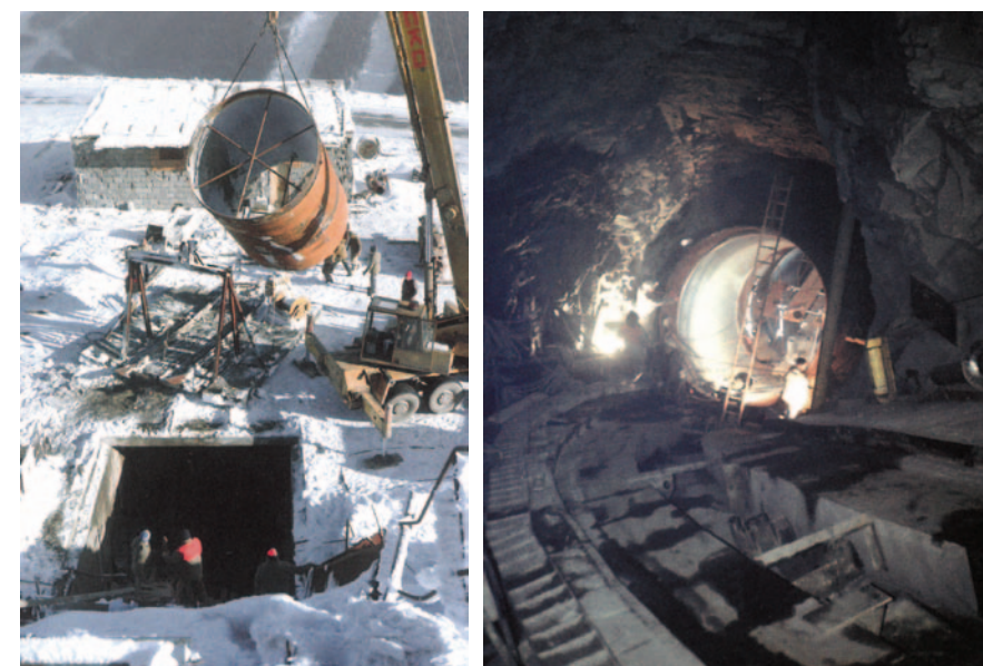
Obr. 4.151: PVE Dlouhé stráně – ukládání ocelového pancíře do přívodní štoly k turbínám (převzato z: Höll, 1997).
