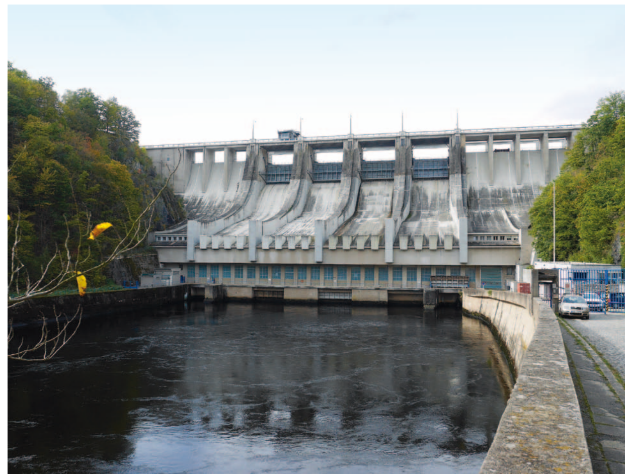
Obr. 4.41: Přehrada Slapy (1949–1957) – tížná betonová přehrada, korunový bezpečnostní přeliv o čtyřech polích hrazený zdvižným segmentem. Foto Viktor Mácha, 2021.
