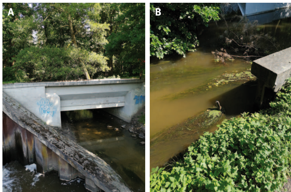
^ Obr. 4.92: Semínský akvadukt na Opatovickém kanále: (A) stav po rekonstrukci; (B) pozůstatky starých dřevěných prvků. Foto David Honek, 2020.
