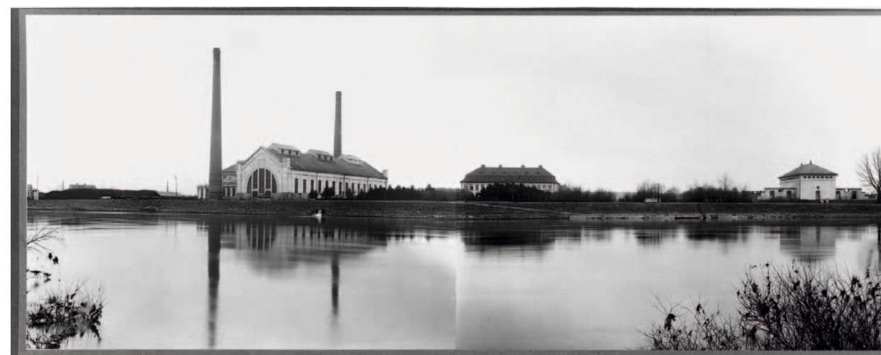
Obr. 4.202: Káraný, Káranánská vodárna – vodárna v obci Káraný na soutoku Labe a Jizery, byla postavena v letech 1896 až 1912, spuštěna 1913, oficiálně 1. ledna 1914. Vodárna je založena na jímání podzemní vody, která vzniká prosakováním říční vody do vhodného, zde štěrko-pískového podloží. Přirozeně profiltrovaná voda je sbírána podzemními nasávacími studněmi. V 60. letech byl proces doplněn umělou infiltrací, spojenou s přímým čerpáním surové vody z řeky na soustavu venkovních pískových filtrů. Vedlejším zdrojem vody je taktéž soustava artézských studní. Původně byla poháněna parními stroji, od 30. let 20. století modernizována na elektrický pohon. Vodárna je stále plně funkční. Od začátku se jednalo o lokální skupinový vodovod, protože původními odběrateli bylo hl. město Praha a jeho předměstí, od druhé poloviny 20. století je na vodu napojena i řada okolních obcí podél hlavního přivaděče. Foto: Archiv PVK, Fotoarchív, kt. N 21, sign. C 083a.
