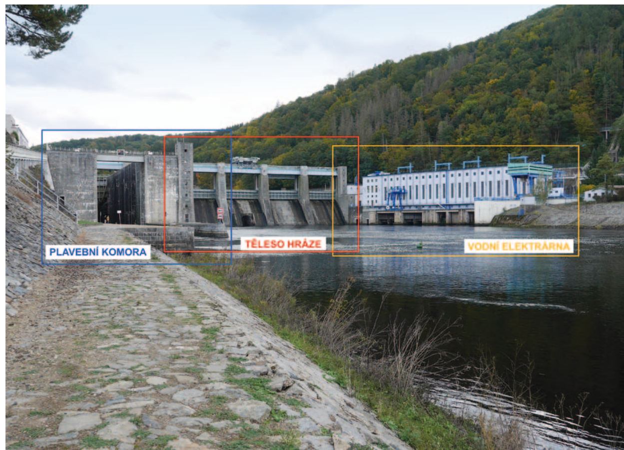
Obr. 4.35: VD Štěchovice (1937–1945) – tížná betonová hráz. Ukázka funkčního celku – přehrada + plavební komora + vodní elektrárna. Foto Michaela Ryškové, 2020.
