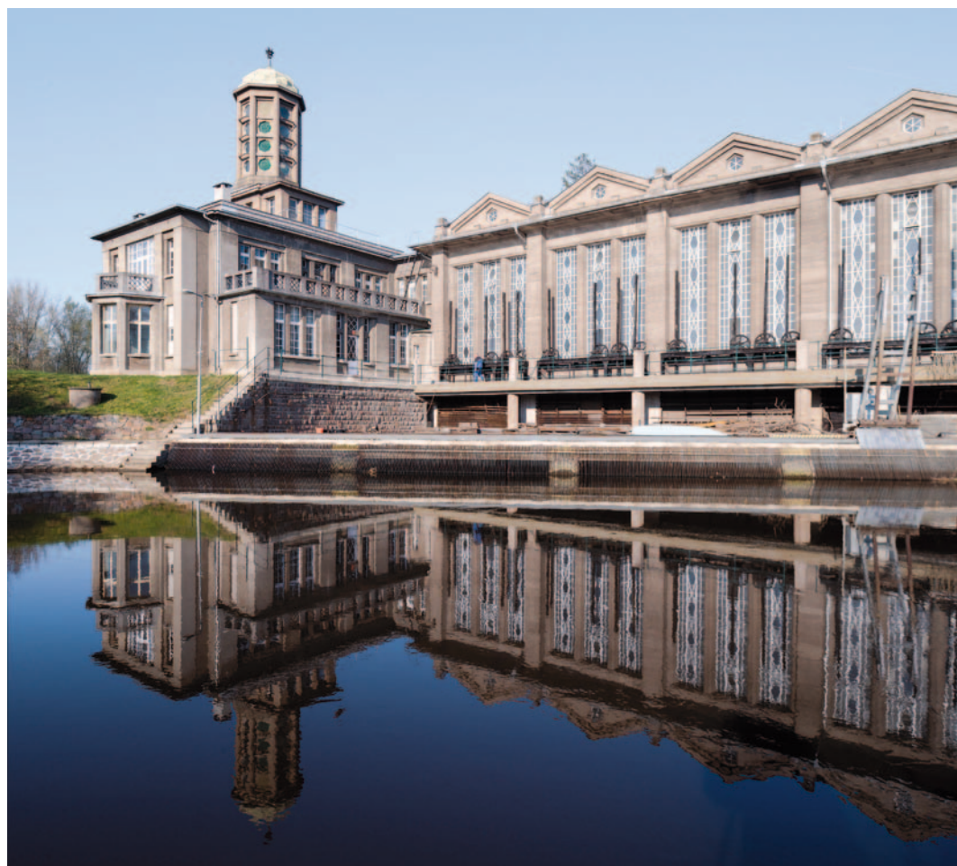
Obr. 3.17: Poděbrady – jez a vodní elektrárna v jednotném architektonickém tvarosloví jsou dílem architekta Antonína Engela. Foto Viktor Mácha, 2019.
