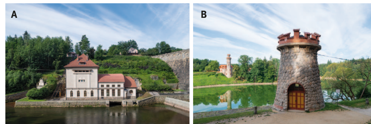
Obr. 4.39: Přehrada Les Království (1910–1919): (A) budova vodní elektrárny; (B) šoupátková věž pro ovládání spodních výpustí v levém obtokovém tunelu, v pozadí domek hrázného. Foto Viktor Mácha, 2020.
