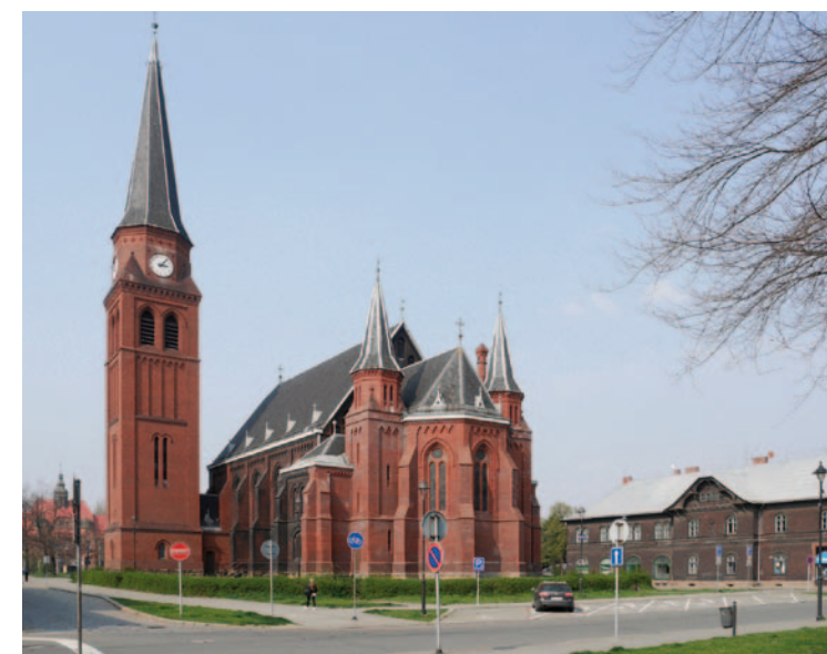
Obr. 4.221: Ostrava-Vítkovice – unikátní věžový vodojem ve věži kostela sv. Pavla v Ostravě-Vítkovicích. Město Nové Vítkovice, založené Vítkovicými železárnami jako zázemí pro rozrůstající se výrobní provozy, bylo budováno od 70. let 19. století. Součástí a významnou dominantou jeho náměstí se mimo radnice stal také kostel sv. Pavla se samostatně stojící věží. Ta byla vystavěna ještě před vlastní chrámovou lodí v roce 1882 a v její horní části byly mimo zvonice a požární pozorovatelný umístěny také dvě nádrže, každá o objemu 50 m 3 . Byly součástí vodovodního systému, na který byly napojeny obytné soubory a další stavby nově budovaného města (Matěj a kol., 1992). Foto Michaela Ryšková, 2019.
