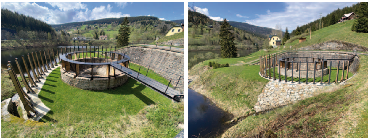
Obr. 4.29: Přehrada Labská (1910–1916) – tížná zděná přehrada, šachtový bezpečnostní přeliv, který podstoupil rekonstrukci v letech 2017–2019. Foto Radka Račoch, 2021.
