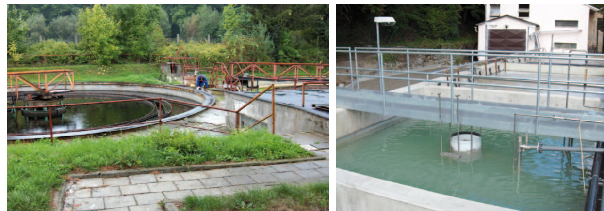
Obr. 4.253: Dosazovací nádrž. Foto archiv VÚV.
