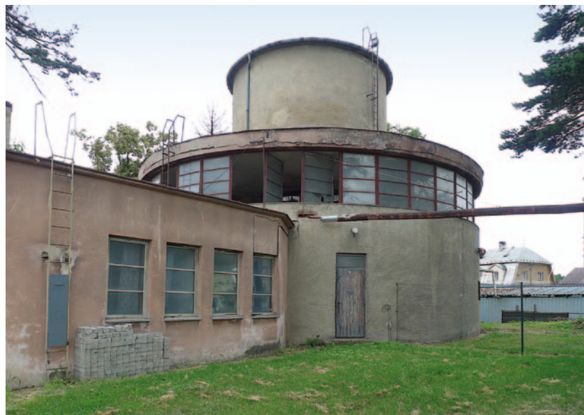
Obr. 4.223: Krnov – věžový vodojem v areálu závodu Karnola. Věžový vodojem neznámé datae a autorství určený pro užitkovou vodu pro textilní závod n. p. Karnola. Vodojem o malé výšce s válcovou nádrží nesenou ocelovými dřívky a architektonicky ztvárněným pláštěm, složeným ze dvou válců různých měřítek a prolomeným dvěma horizontálními pásy oken. Byl zbořen v roce 2020. Foto Michaela Ryškové, 2013.
