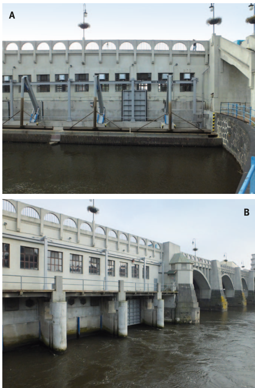
Obr. 4.141: MVE Kolín: (A) vtokový objekt; (B) výtokový objekt. Foto VUT v Brně, FAST, 2015.
