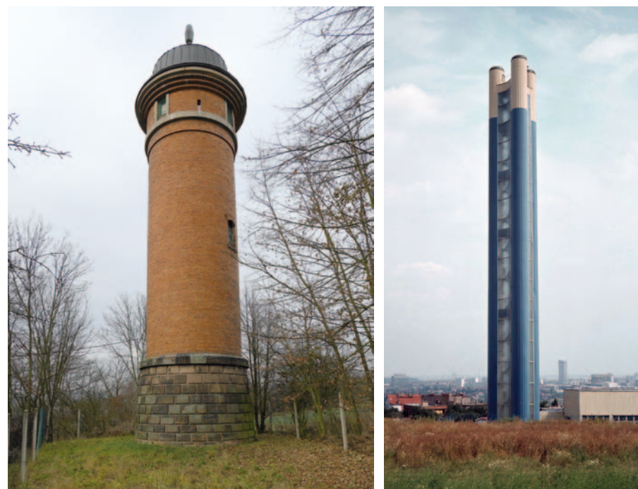
Obr. 4.225: Odlehčovací a vyrovnávací věže vodovodů: (A) Letovice – odlehčovací věž I. březovského vodovodu pro zásobování Brna pitnou vodou; (B) Praha – vyrovnávací věž Děvín postavená podle návrhu arch. Karla Hubáčka, SIAL. Foto (A) Michaela Ryšková, 2016; (B) Archiv PVK, f. Fotoarchív PVK, kt. N 8, sign. B 9516.
