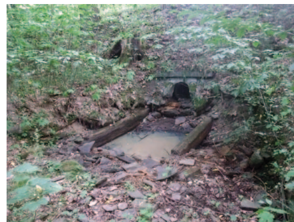
Obr. 4.62: Zbýšov (okres Kutná Hora) – spodní výpust' zaniklého Nového rybníka s dochovanými relikty podtrubní jámy a vývaru. Foto Jindřich Frajer, 2020.
