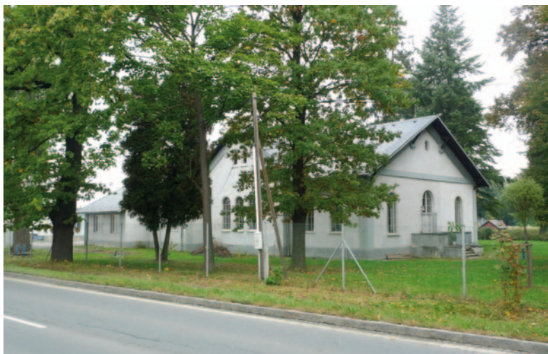
Obr. 4.194: Opava – areál vodárny v ulici Jaselská z roku 1875 s objektem původní parní strojovny. Foto Alena Boroucová.
