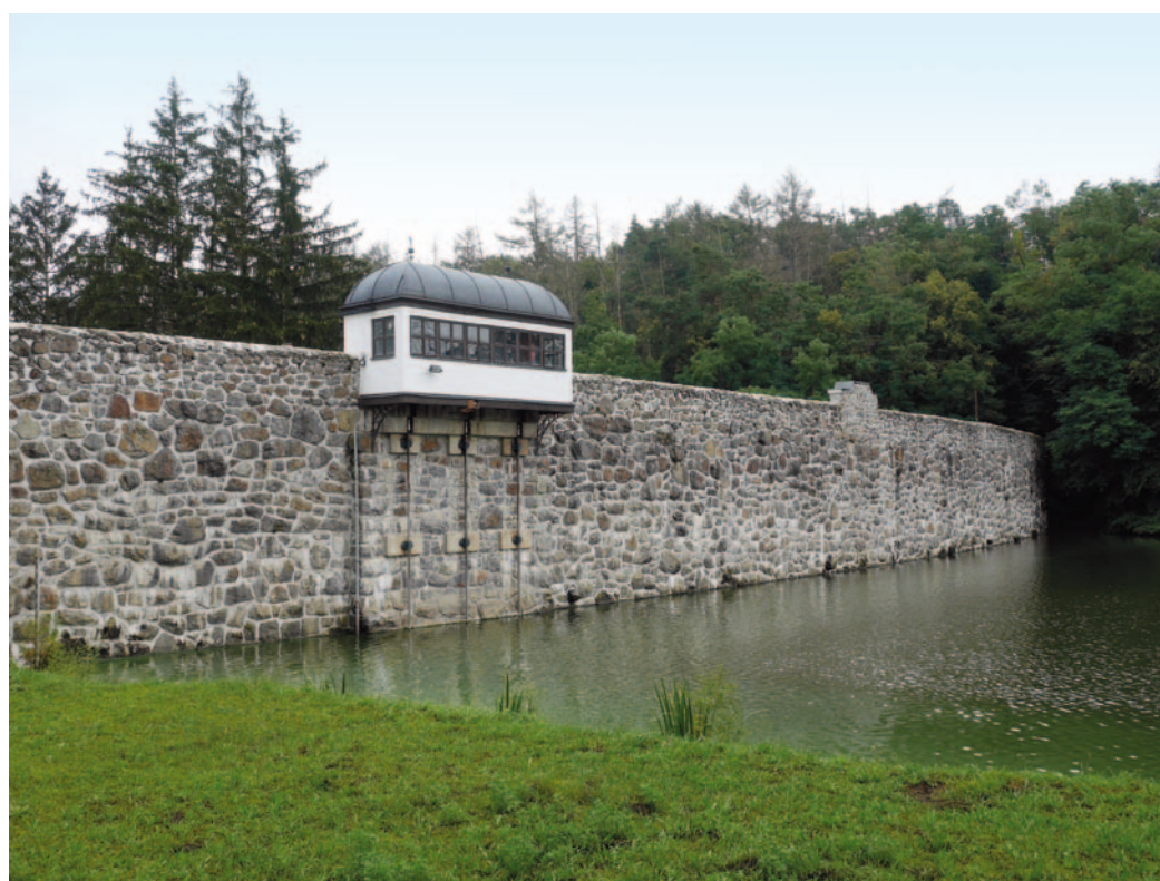
Obr. 3.7: Přehrada Jevišovice (1884–1896) – jedna ze dvou nejstarších zděných přehrad na území ČR. Autenticita formy byla narušena úpravou koruny hráze a dostavbou objektu strojovny ovládacích mechanismů spodních výpustí. Dobová pohlednice, sbírka M. Ryškové; foto Michaela Ryškové, 2020.
