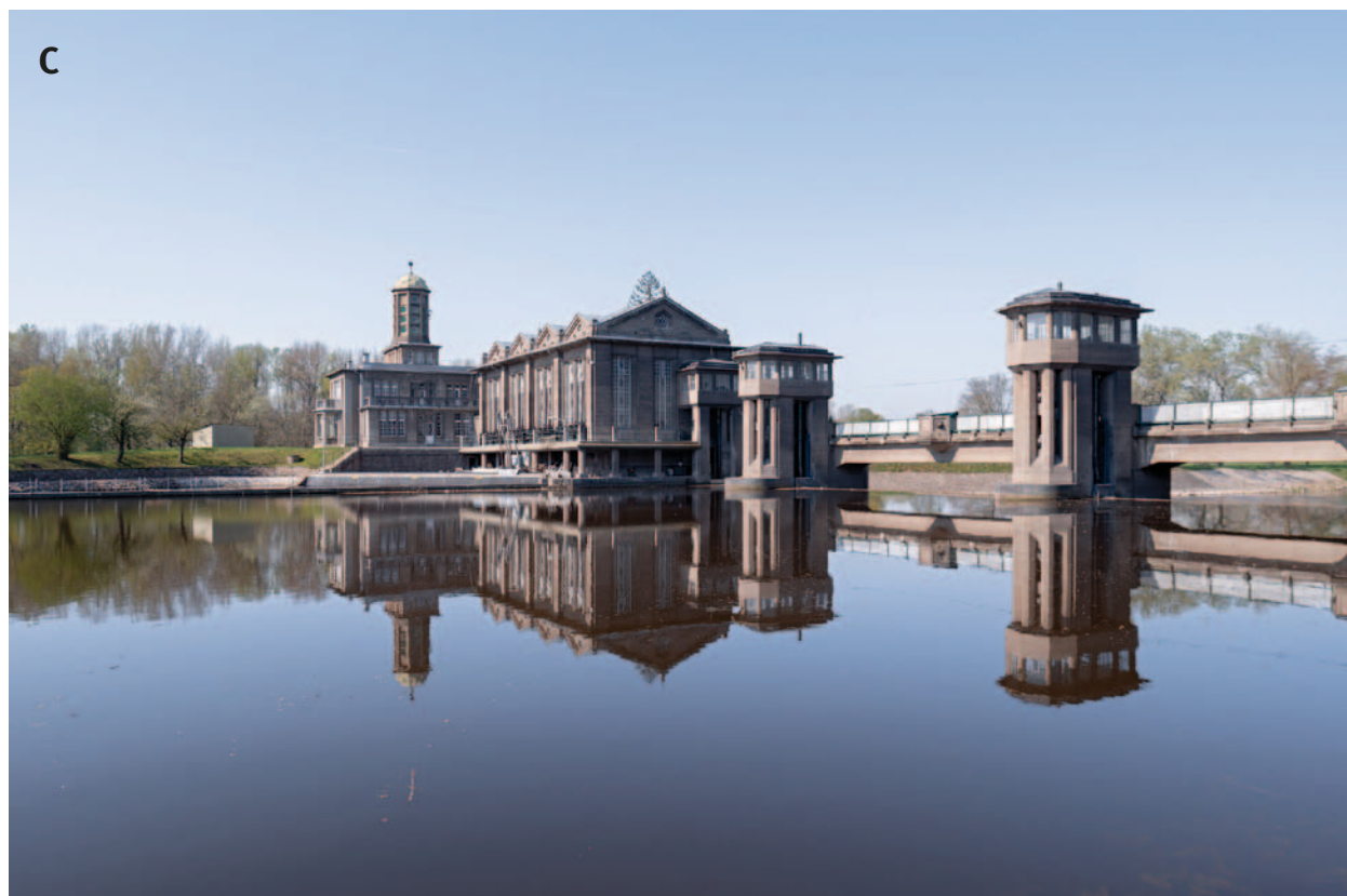
Obr. 4.121: Situace v lokalitě funkčního celku stupeň Poděbrady: (C) pohled na jez s vodní elektrárnou. Foto Viktor Mácha, 2019.
