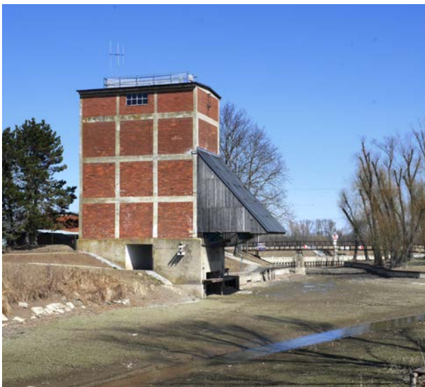
Obr. 4-1 Batův kanál byl součástí energetického systému Batových závodů ve Zlíně. Je funkčním celkem zahrnujícím řadu objektů zajišťujících dopravu lignitu z dolů v Ratíškovcích k závodní elektrárně v Otrokovicích. Jeho součástí jsou umělé toky, jezy, plavební komory a další objekty na této vodní cestě, včetně obytných domů pro zaměstnance. Na snímku výklopník uhlí do nákladních člunů v Sudoměřicích (foto Michaela Ryšková, 2022).
