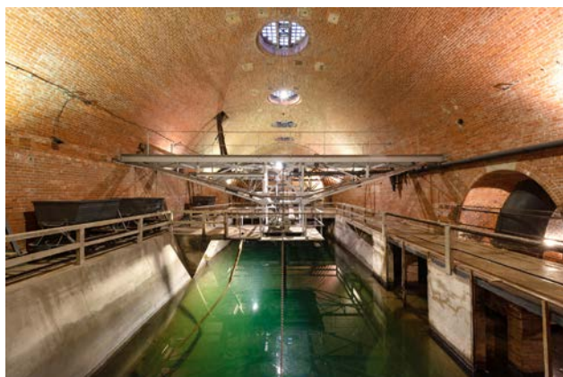
Obr. 4-7 Praha, Stará čistírna odpadních vod v Bubenči patří k nejvýznamnějším evropským příkladům řešení problému nakládání s odpadními vodami, jež byla v evropských městech různými způsoby řešena na konci 19. století. Byla navržena Williamem H. Lindleyem v roce 1894 (foto Viktor Mácha, 2020).
