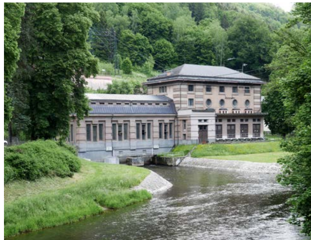
Obr. 4-4 Spálov, vodní elektrárna. Soubor budov vodní elektrárny z let 1921–1926 v tzv. „národním stylu“ je dílem architekta geometrické secese a kubismu Emila Králíčka (Lukeš a kol., 2005; KP) (foto Michaela Ryšková, 2022).
