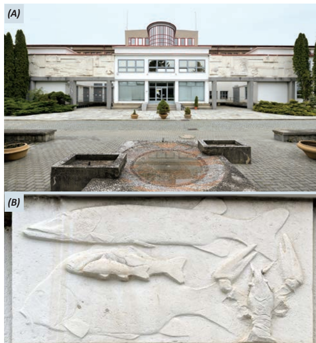
Obr. 4-5 (A) Vítov, úprava vody Podhradí s reliéfem (B) Voda v našem životě sochaře Vincence Makovského, vytvořeným v letech 1961–1964 (KP) (foto Roman Polášek, 2019).
