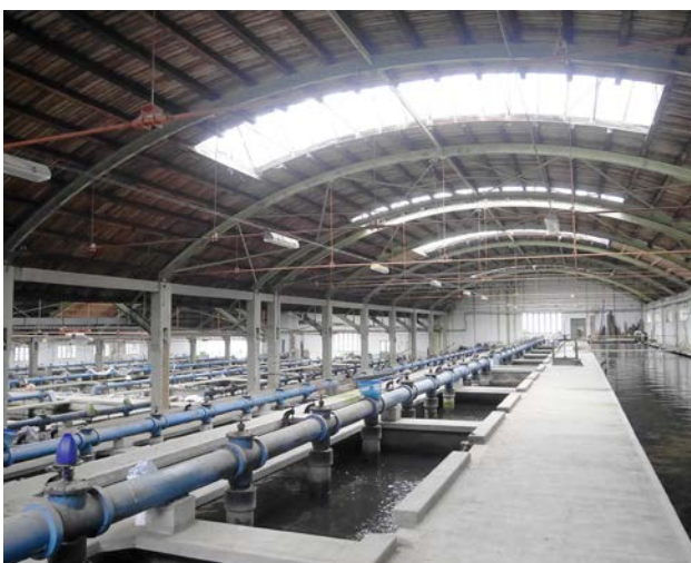
Obr. 4-2 Plzeň, Puech-Chabalova filtrace městské vodárny Na Homolce. Nedostatečná kvalita vody dodávaná městskou vodárnou vybudovanou na konci 19. století vedla ve 20. letech 20. století k rozšíření technologie čištění o filtrační systém Puech-Chabal. Na území dnešní ČR byly instalovány pouze tři tyto systémy a plzeňský příklad je jediným dochovaným, navíc dochovaným v autentické podobě. Současné využití pro rybí sádky využívá typologických daností stavby bez zásahů do stavební podstaty nebo technického zařízení (foto Michaela Ryšková, 2020).
