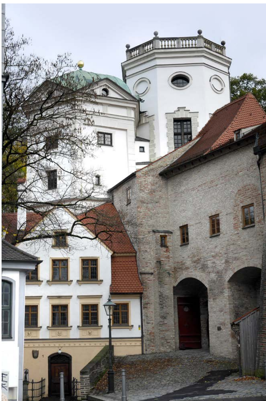
Obr. 12-19 Velká a Malá věž Horní vodárny u Červené brány; u paty věží se nachází dům správce (foto Michaela Ryšková, 2019).
