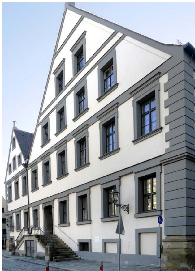
Obr. 12-23 Jatka z roku 1609 byla chlazena vodou z kanálu, který procházel pod budovou (foto Michaela Ryšková, 2019).
