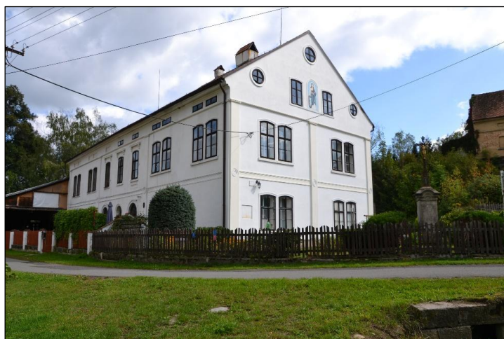
Obr. 4.7 Celkový pohled na mlýn č. p. 87 v Lindavě, náhon přitéká od odvrácené strany, vpravo dole vyústění odtokového kanálu (foto: M. Kolka, září 2019).
