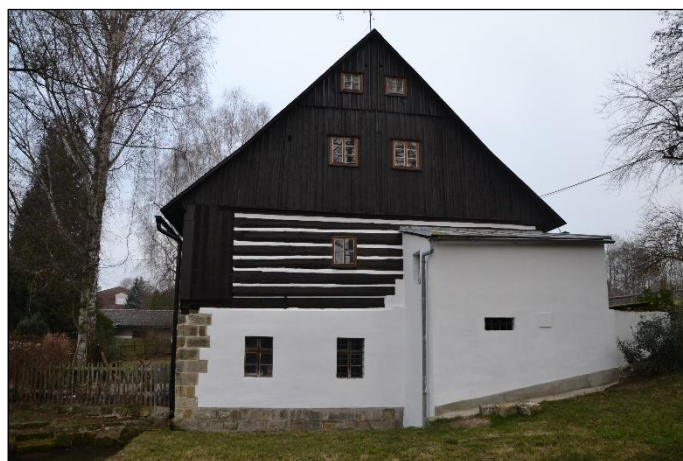
Obr. 3.16 Markvartice, mlýn č. p. 44, velmi dobře zachovaná budova barokního mlýna s torzy technologického zařízení, stojí pod hrází rybníka Markvart, nejstarší částí je sklep (1704), roubená část síně v přízemí a celé patro (1710-1712), světnice a nová zděná světnička v přízemí byly přistavěny kolem roku 1835, ve zděné přístavbě nad náhonem je zachována téměř kompletní Francisova turbína (foto: M. Kolka, prosinec 2019).
