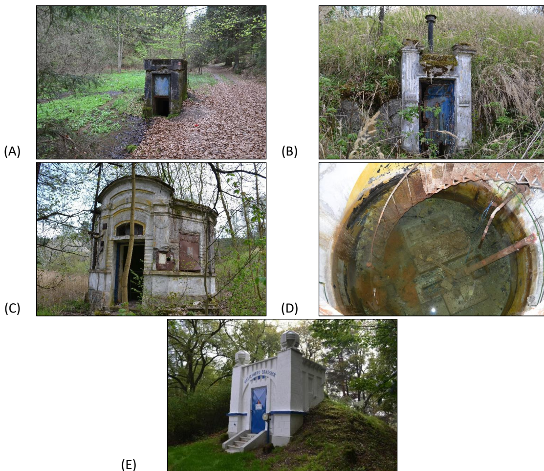
Obr. 5.6 Objekty vodovodu v Dražejově, (A) sběrná komora v Pramenném dole, (B) vodní zámek, (C) čerpací stanice – exteriér, (D) čerpací stanice – interiér s fundamenty pro osazení turbíny, ležatého pístového čerpadla a vzdušníku, (E) vodojem (foto: M. Kolka, březen, duben, říjen 2014).
