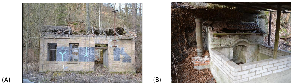
Obr. 5.9 (A) zaniklá čerpací stanice zámeckého vodovodu na Novém Berštejně, (B) Mariánský pramen (foto: M. Kolka, březen 2014).
