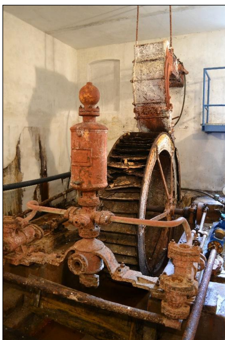
Obr. 5.16 Snímek unikátně zachovaného zařízení čerpací stanice pro Pavlovice ještě na původním místě před rozebráním a deponováním. Vpředu dvojice ležatých pístových čerpadel se vzdušníkem a za nimi vodní kolo s vantrkovým žlabem (foto: M. Kolka, červenec 2014).
