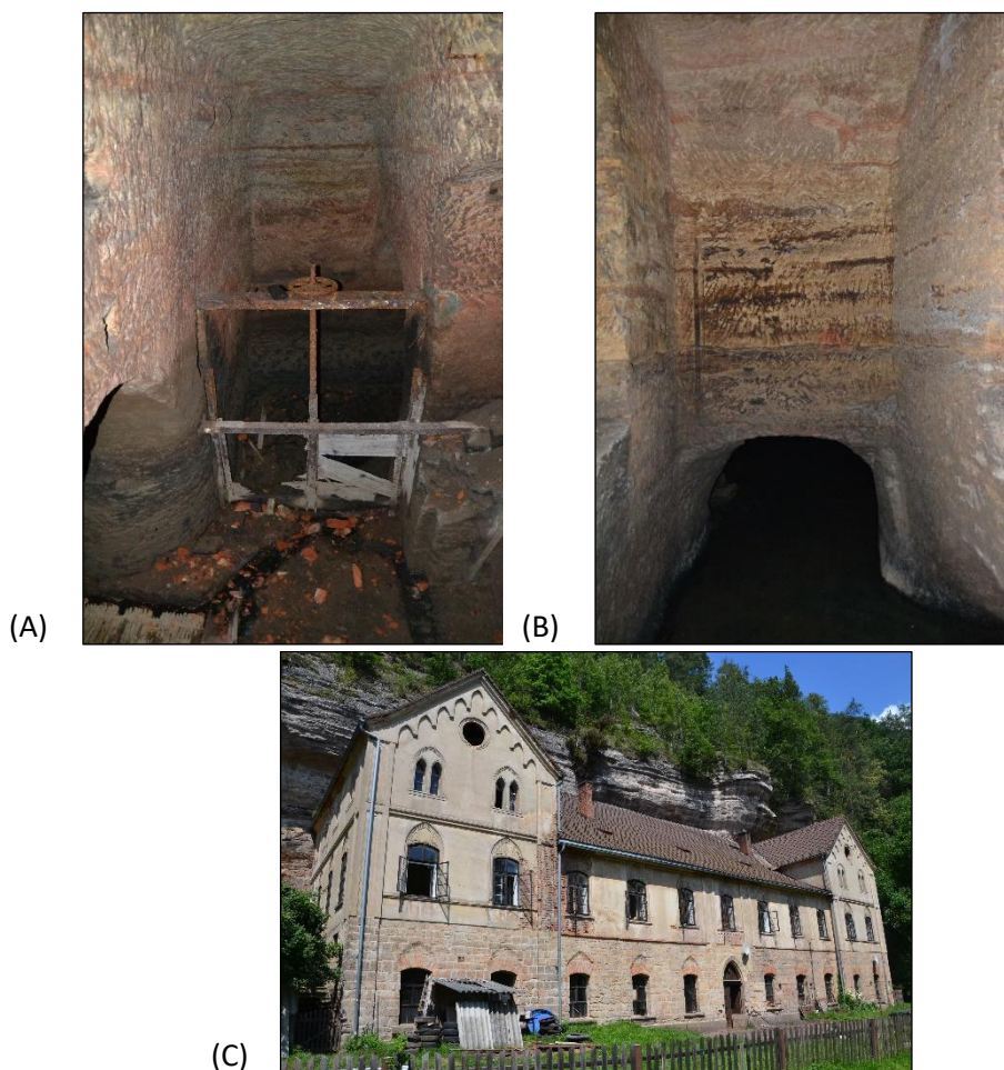
Obr. 4.10 Nahoře vlevo koncová část náhonu s torzem stavidla a česel a stavidlem do jalové obtokové skalní štoly, lednice je vpravo. Na pravém snímku pohled od stavidel do lednice s odtokovým kanálem. Dole celkový pohled na brusírnu a leštírnu zrcadel č. p. 308 v Lindavě (foto: M. Kolka, červenec 2020).
