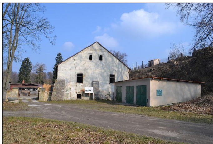
Obr. 5.4 Snímek polohy zaniklé čerpací stanice zámeckého vodovodu v Doksech. Stála v místech garáží před průčelím pivovaru č. p. 17 (foto: M. Kolka, březen 2014).
