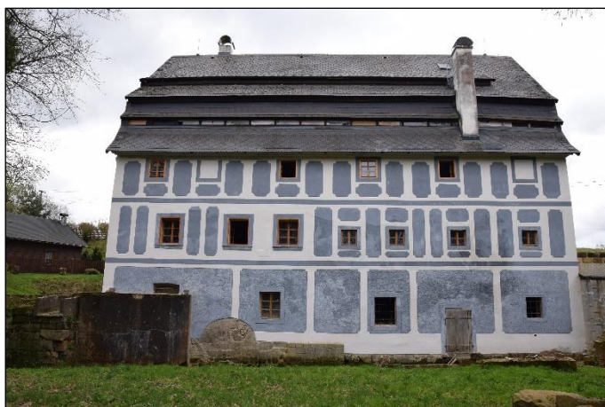
Obr. 3.13 Hamr na Jezeře, papírna č. p. 5, mezi stavby nepochybně převyšující svým významem hranice oblasti bezpochyby náleží tato unikátně zachovaná papírna s torzy strojního zařízení z přelomu 19. a 20. století, objekt se zděným přízemím a hrázděným patrem pochází z osmdesátých let 17. století (foto: M. Kolka, duben 2017).
