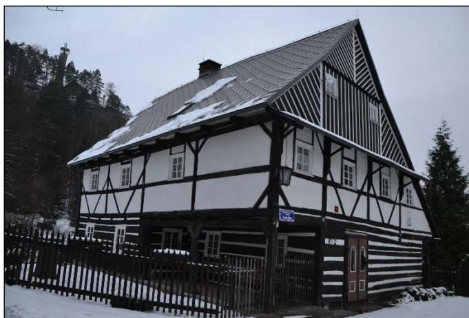
Obr. 3.8 Sloup v Čechách, mlýn č. p. 117, náleží mezi nejcennější mlýnské budovy v regionu, pochází z doby kolem roku 1757 a kombinuje roubené přízemí s podstávkou u obytné části, hrázděné patro a velmi zajímavou podsíň, mlýnice je umístěna za podsíní a zabírá celou pravou polovinu stavby (foto: M. Kolka, prosinec 2021).
