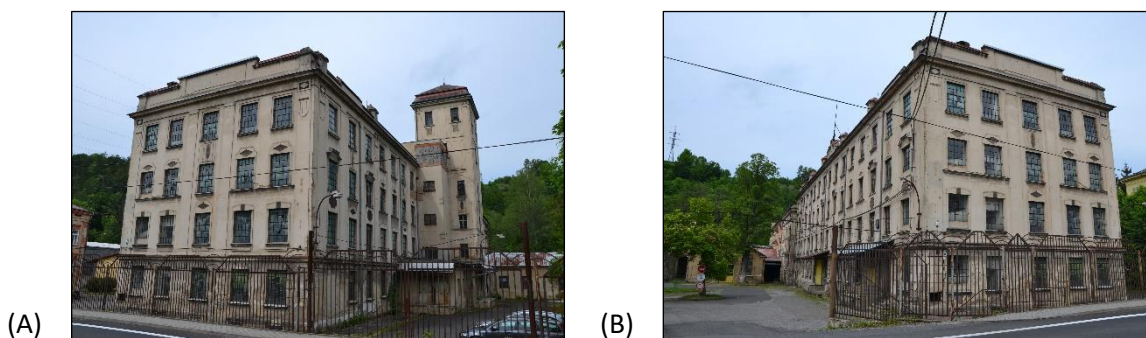
Obr. 6.4 Františkov nad Ploučnicí, přádelna č. p. 77, pohledy na přádelnu od silnice, vlevo navazující sprinklerová věž (foto: M. Kolka, květen 2022).
