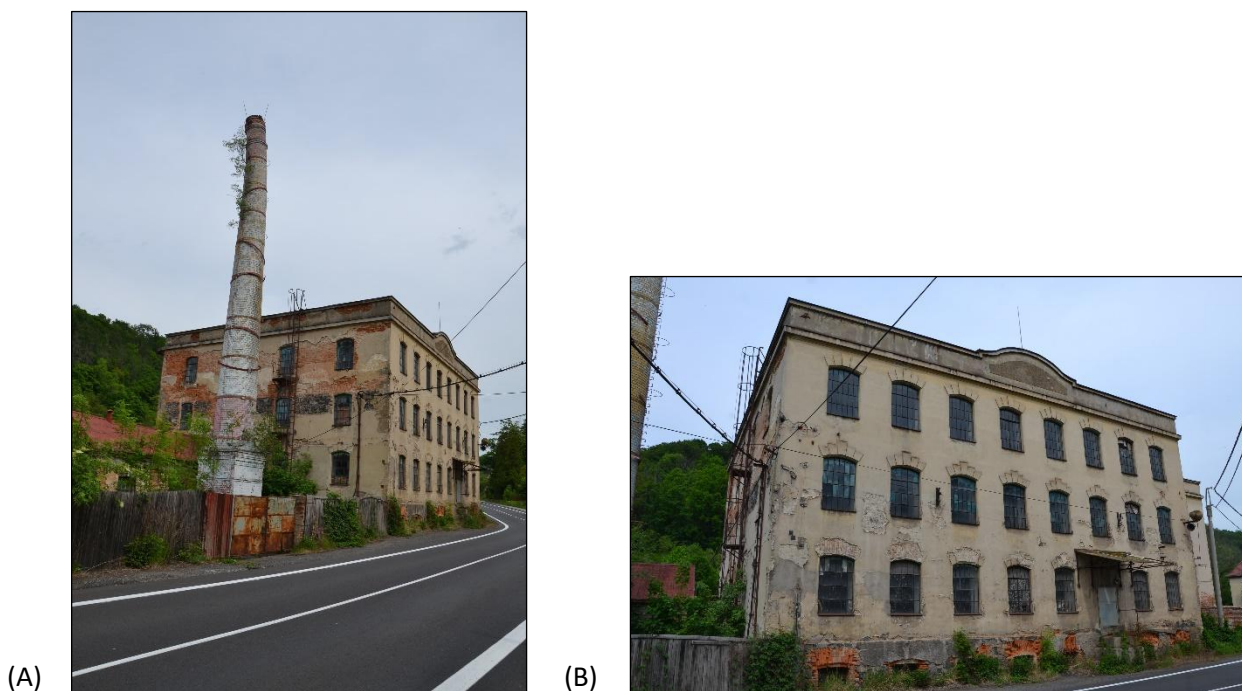
Obr. 6.3 Františkov nad Ploučnicí, přádelna č. p. 125, (A) pohled na hlavní objekt s továrním komínem a kotelnou, (B) hlavní průčelí přádelny (foto: M. Kolka, květen 2022).
