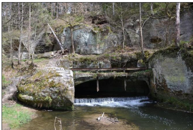
Obr. 4.2 Jez vodního díla brusírny a leštírny zrcadel č. p. 309 a 311. Práh je osazen mezi přisekané skalní stěny. Voda na jez přitéká z levé strany krátkou zalomenou štolou mimořádných parametrů. Náhon odbočuje opět skalní štolou před jezem směrem doprava. Stavidlový jez pochází z úpravy, provedené v roce 1917 (foto: M. Kolka, duben 2020).
