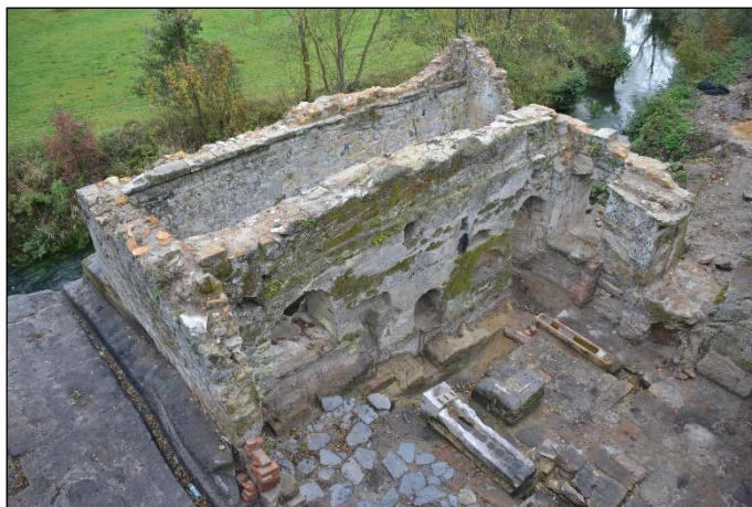
Obr. 3.4 Velký Grunov, kostní stoupa a olejna v usedlosti č. p. 95, pohled na vykopané torzo stavby před opětovným zastřešením, krátký náhon na levém břehu Panenského potoka ústí do mohutné lednice, kde bylo osazeno vodní kolo na spodní vodu, vpředu odkrytá podlaha pracovního sálu s torzy štoků pro tyčové stoupy, velká část stavby včetně lednice a odtokového kanálu se sekaná do pískovcového podloží (foto: M. Kolka, říjen 2012).
