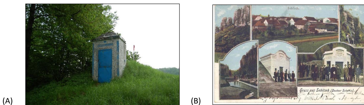
Obr. 5.8 (A) vodojem u osady Sušice (foto: M. Kolka, květen 2012), (B) pohlednice z roku 1909 zachycuje v dolních okénkách dokončený vodovod, vlevo jez, uprostřed vodojem u Poustky a vpravo čerpací stanici v údolí Dolského potoka (zdroj: sbírka Stanislava Dulíka).
