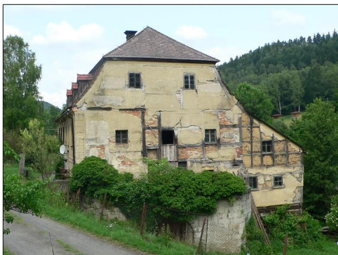
Obr. 3.5 Heřmanice, mlýn č. p. 117, objekt na Heřmanickém potoce velmi zajímavým způsobem kombinuje zděný, hrázděné a roubené konstrukce, náleží mezi nejautentičtější zachované mlýny v oblasti (foto: M. Kolka, červen 2013).
