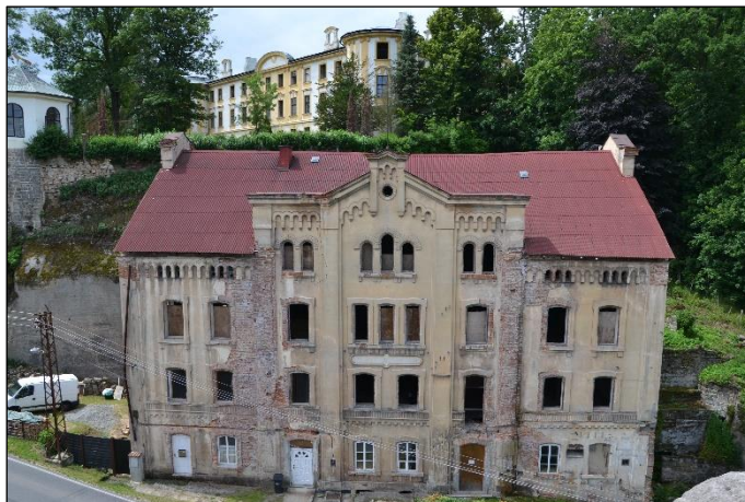
Obr. 3.9 Zahrádky, mlýn č. p. 34, mohutná historizující budova z roku 1865 stojí pod zámeckou ostrožnou, zařízení poháněla dvě kola na horní vodu, umístěná před v lednici před průčelím, dlouhý náhon ke mlýnu vedl až od dolního konce Novozámecký průrvy, na pravé nároží navazovala zaniklá čerpací stanice zámeckého vodovodu (foto: M. Kolka, červen 2020).
