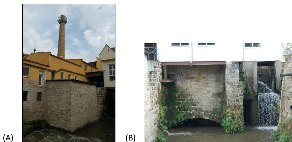
Obr. 6.9 Děčín, elektrárna č. p. 1259/10, (A) celkový pohled od odtokového kanálu, (B) detail výtoku z turbínové kašny (foto: M. Kolka, červenec 2012).
