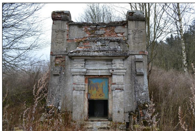
Obr. 3.17 Bohatice u Zákup, vodojem sloužící k zásobování Zákup vodou, vodovod byl vystavěn mezi lety 1913-1914 podle plánů firmy L. Bill & Comp. z Podmokel (dnes součást Děčína), ve vodojemu se shromažďovala voda z prameniště na hranicích katastrů Bohatic a Pertoltic pod Ralskem, z vodojemu se pak gravitačně vedla do Zákup (foto: M. Kolka, únor 2014).
