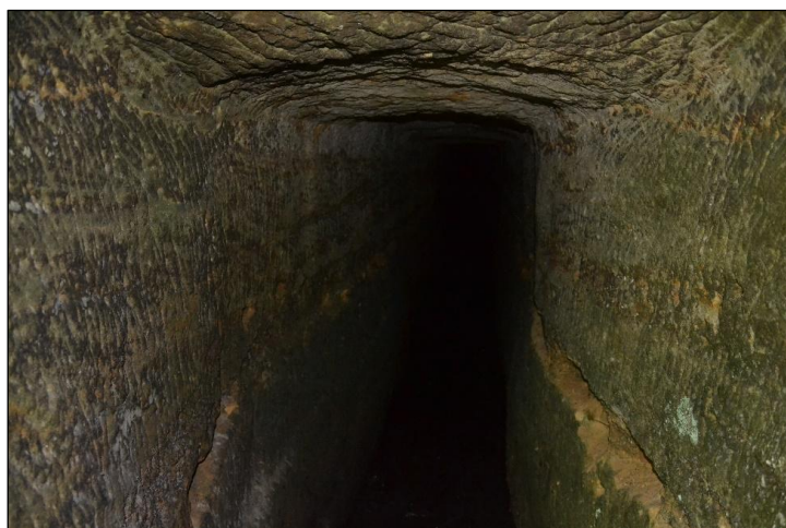
Obr. 4.12 Impozantní odtoková skalní štola, odvádějící vodu z lednice někdejší přádelny č. p. 204 v Mařenicích (foto: M. Kolka, červen 2019).
