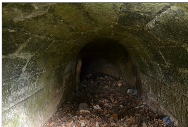
Obr. 4.6 Pohled od ústí zakryté části náhonu mlýna č. p. 87 v Lindavě, za klenutou partií následuje sekaná skalní štola až do lednice (foto: M. Kolka, září 2019)
