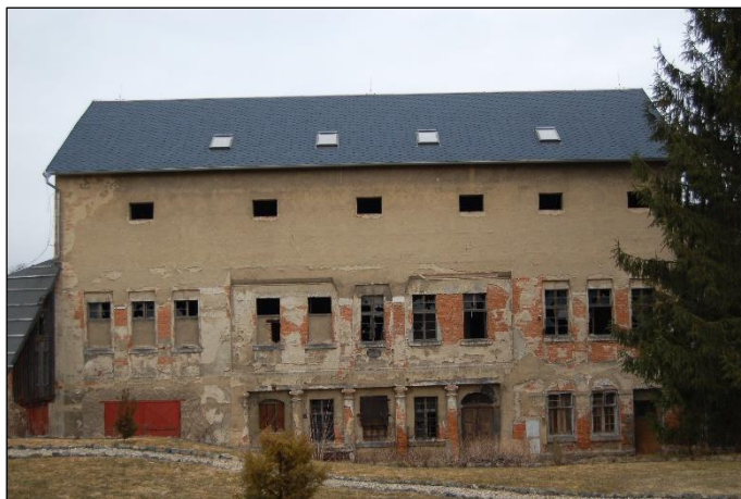
Obr. 3.6 Hlemýždí - Jáchymov, mlýn č. p. 35, velmi hodnotný klasicistní mlýn s mimořádně rozsáhlou mlýnicí (levá polovina) pro 4 mlecí složení, nachází se na náhonu z Panenského potoka a poháněla jej kolo na spodní vodu, od roku 1908 fungoval jako družstevní mlýn (foto: M. Kolka, březen 2011).
