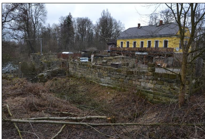
Obr. 3.3 Brenná, mlýn č. p. 37, mohutný náhon z Ploučnice ústil do lednice a později turbínové kašny u torza základů zdiva mlýnské budova, vlevo mimo záběr stála na druhé straně náhonu pila, v pozadí obytná budova (foto: M. Kolka, únor 2019).
