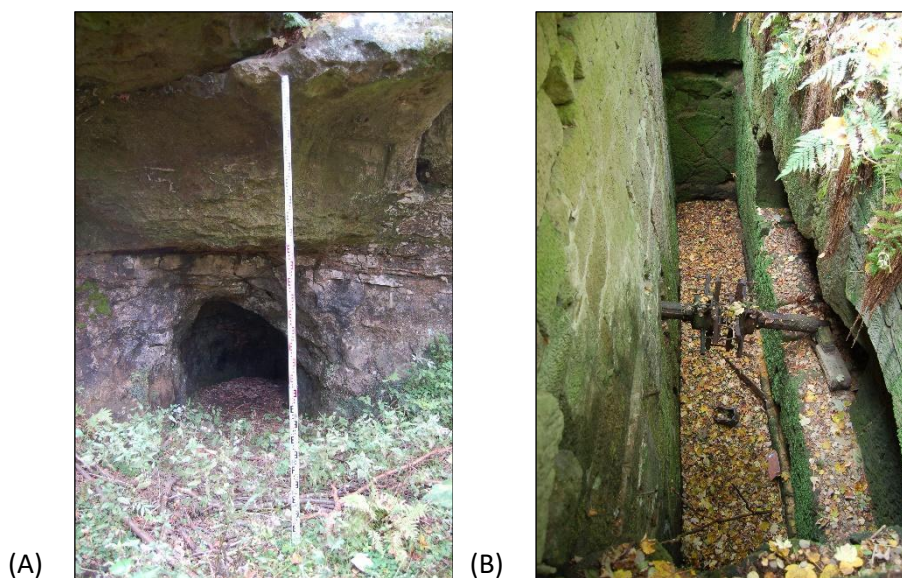
Obr. 4.4 Mlýn č. p. 161 v Dolní Světlé, (A) ústí skalní štoly náhonu, na pravé straně nahoře přisekaný rámeček s nápisem a datací 1864 (patrně souvisí s úpravou, nebo prodloužením náhonu), (B) pohled do hluboké lednice s torzem vodního kola (foto: M. Kolka, říjen 2012).
