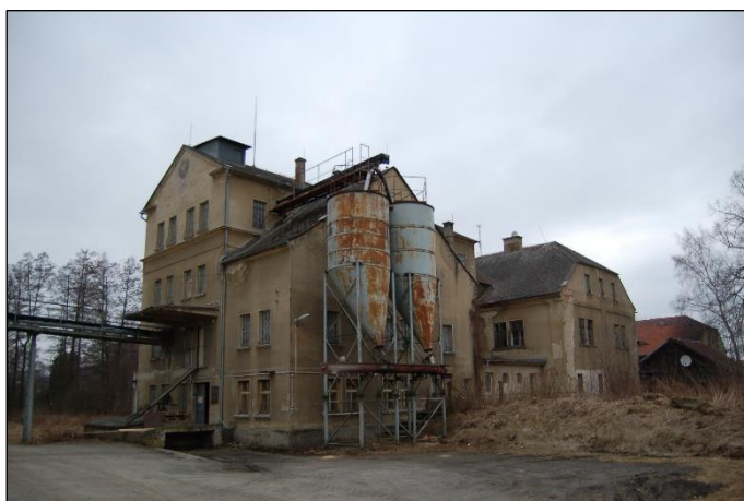
Obr. 3.7 Hlemýždí - Jáchymov, mlýn č. p. 24, rozsáhlý areál s několika rozšiřovanou mlýnicí válcového mlýna (doposavad v provozu), obytnými a hospodářskými budovami (v pozadí), nachází se na náhonu z Panenského potoka a poháněla jej kol na spodní vodu, na počátku dvacátých 20. století nahrazené Francisovou turbínou (foto: M. Kolka, březen 2011).
