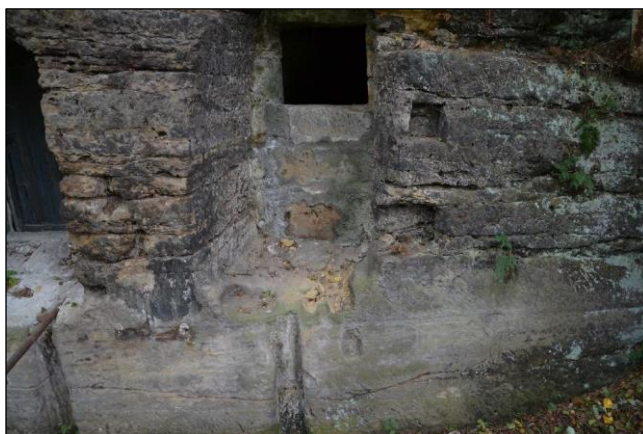
Obr. 4.14 Pohled na skalní stěnu pod nádrží mlýna č. p. 77 v Radvanci, patrné jsou dráže po stavidlech, vlevo vodoprávní značky (otisk skoby a trojúhelník), vpravo datace 1701, koryto před stěnou sloužilo pro odvod jalové vody (foto: M. Kolka, říjen 2019).
