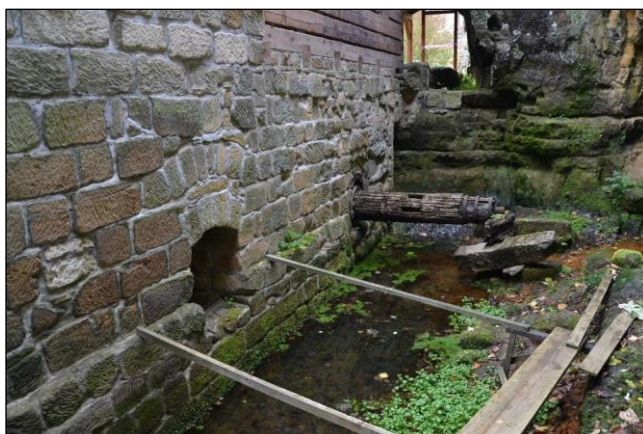
Obr. 4.15 Pohled do lednice mlýna č. p. 77 v Radvanci s hřídelí vodního kola na horní vodu, vlevo otvor pro hřídel druhého druhotně přidaného vodního kola (foto: M. Kolka, říjen 2019).
