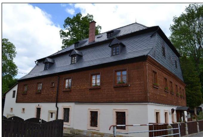
Obr. 3.14 Skalice u České Lípy, mlýn č. p. 269, velmi dobře zachovaná budova pozdně barokního mlýna z doby kolem roku 1762, přízemí je zděné a patro roubené s regionálně typickým obložením (foto: M. Kolka, květen 2017).
