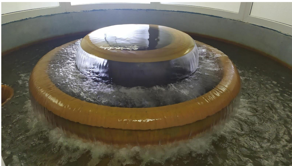
Obr. 31 Kašnový přeliv nového vodojemu 1000 m 3 (Létal, červenec 2021)
