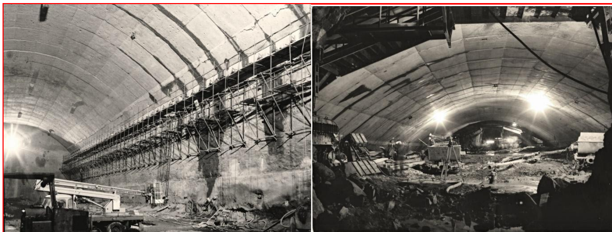
Obr. 15 Detaily stavby betonové klenby v roce 1985 Zdroj: MELZER, SCHULZ, Vlastivěda šumperského okresu.
