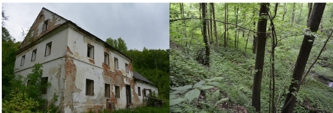
Obr. 36 Pohled na budovu Schilderova mlýna a na zbytky náhonu v lese (R. Pavelková, 2021)
