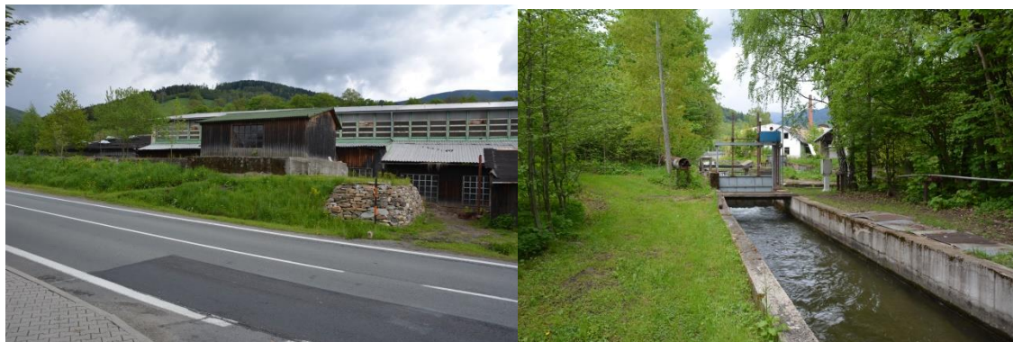
Obr. 41 Současný stav objektu MVE Rejhotice III. a náhonu se stavidly
