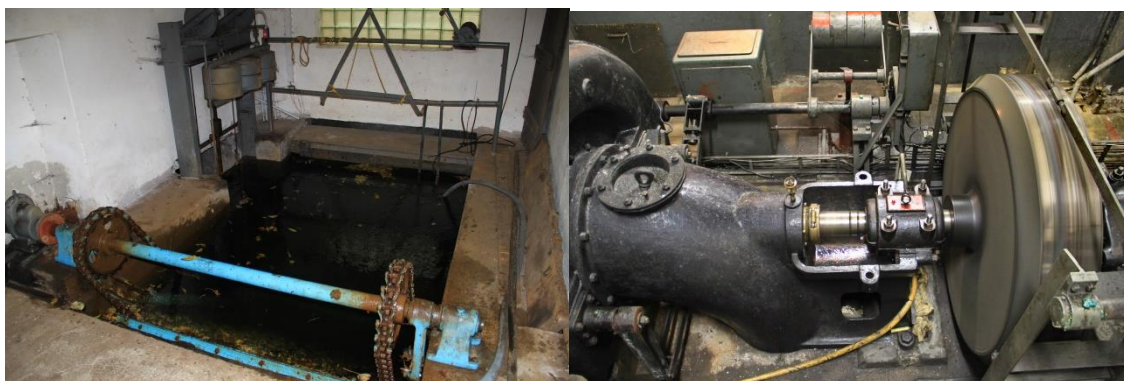
Obr. 34 Detaily strojovny MVE Loučná II. (R. Jašš, 2017)
