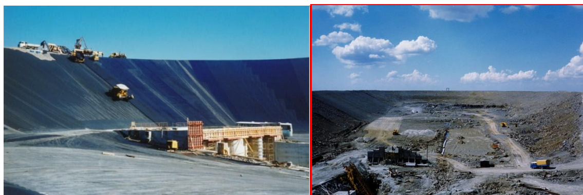
Obr. 9 Rozpracovaná horní nádrž v roce 1990 (vlevo) a dokončování pokládky asfaltobetonového těsnění hráze v roce 1992 (vpravo)
