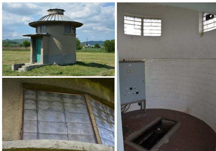
Obr. 26 Stavební detaily jímací studny na prameništi Luže: Objekt I - vlevo nahoře, detail skleněných tvárnic – vlevo dole, interiér objektu - vpravo (Létal, květen 2021)
