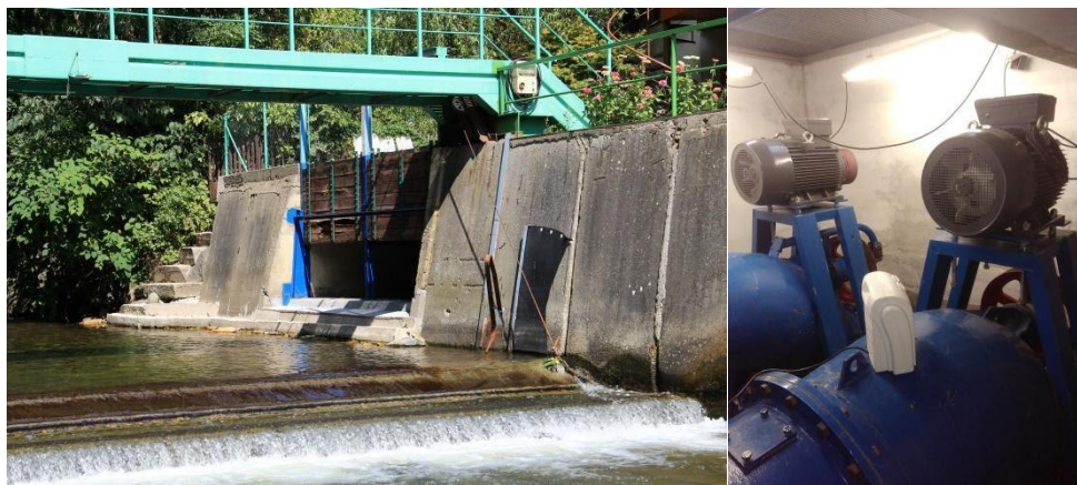
Obr. 42 Objekt MVE Vikýřovice (ul. Rybářská) s detailem vtoku návodního kanálu z řeky Desná a vybavení objektu strojovny (R. Pavelková, 2021 a R. Jašš, 2018)
