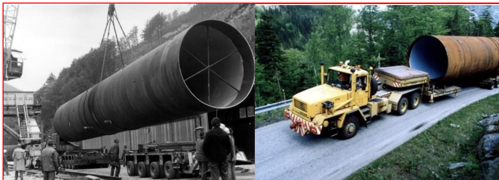
Obr. 18 Ukládání pancíře délky 24 m a hmotnosti 101 t na podvalník (1991) Doprava dílu délky 18 m a hmotnosti 45 t k horní nádrži (1992)
