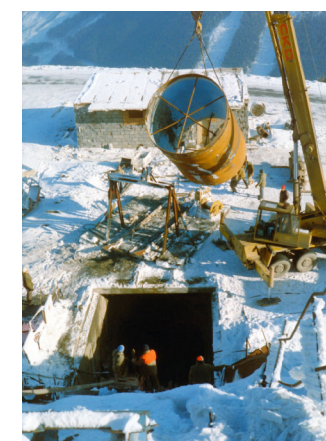
Zavážení pancíře horního lomového kolena (1993)
