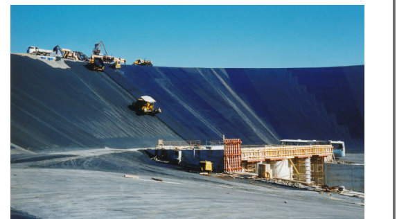
Horní nádrž s vtokovým objektem, dokončování pokládky AB pláště (1992)
