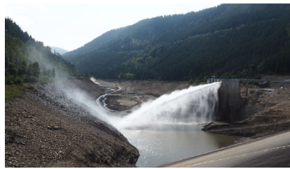
Vypouštění přiváděče Peltonovou džózou (2018)
