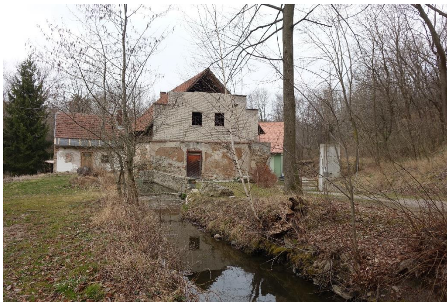
Obr. 39 Bývalý mlýn v Krchlebech. Současný stav. (foto: J. Frajer)
