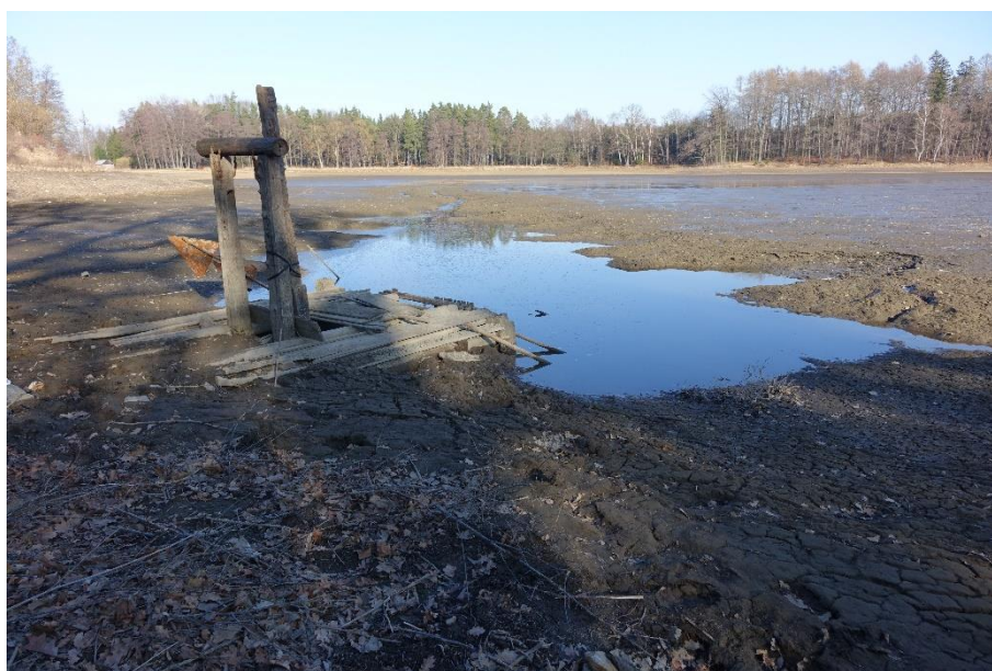
Obr. 11 Ovládání spodní výpusti Zbýšovského rybníka (t.č. vypuštěného) (foto: J. Frajer)
