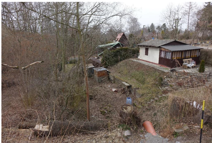
Obr. 10 Vyústění trubky z bývalého náhonu na mlýn ve Zbýšově. Chata je postavena na navážce, mlýn byl umístěn v úrovni dnešních schodů. (foto: J. Frajer)
