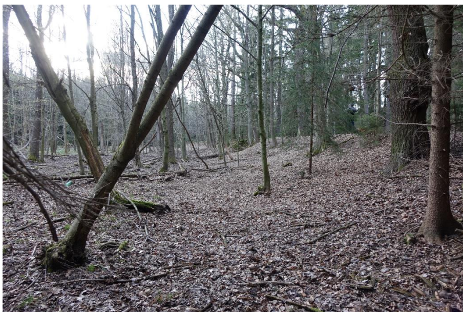
Obr. 6 Návodní strana hráze a bývalé dno Malého Komárovského rybníka (foto: J. Frajer)
