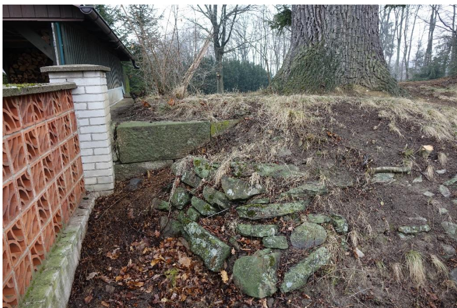
Obr. 13 Detail dochovaného reliktu tarasu a splavu v boční „malé“ hráze Zbýšovského rybníka
