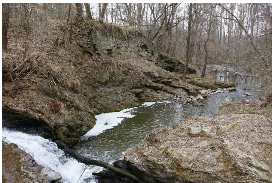
Obr. 37 Současný jez a přepad Klejnárky. Na levém břehu viditelný relikt hráze Velkého Netušila s opevněním bývalého splavu a otvory pro dřevěné prvky stavidel (foto: J. Frajer)
