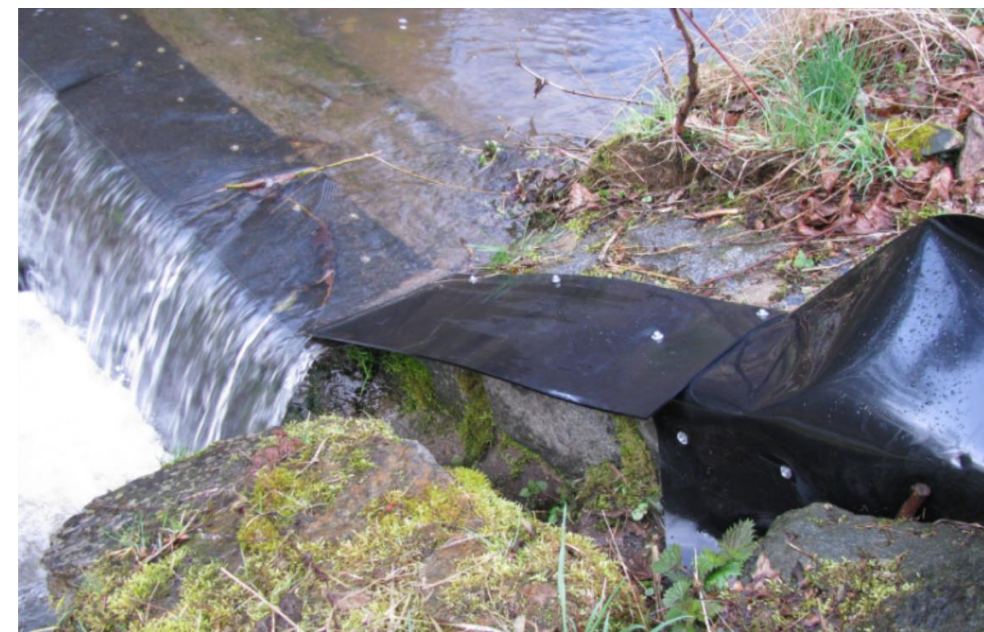
Obr. 31. Migrační bariéra – doplnění koruny stávajícího příčného objektu o horizontální prvek s přesahem (bokorys) – © D. Fischer
