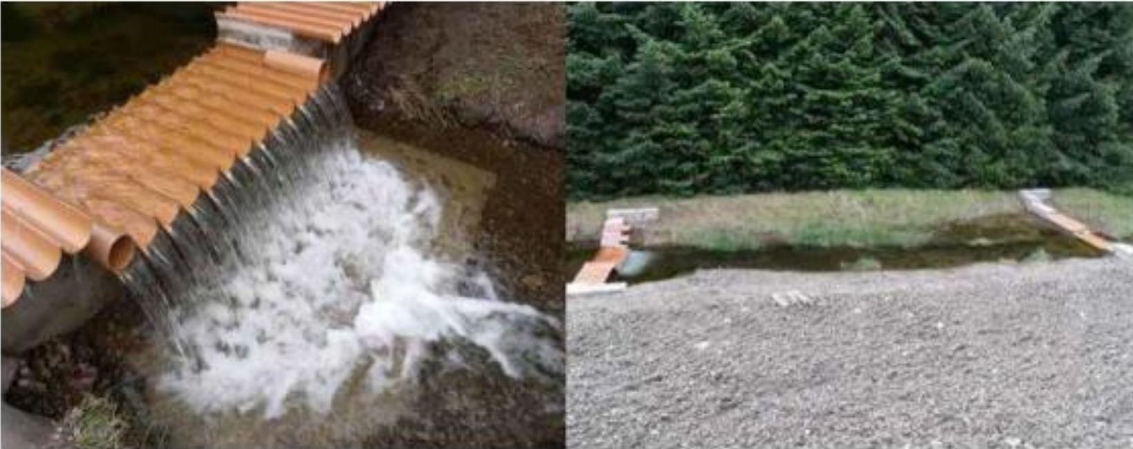
Vytvoření menších překážek na toku, úprava koruny jezu a bočních bariér (Bean et Yeomans 2016)
