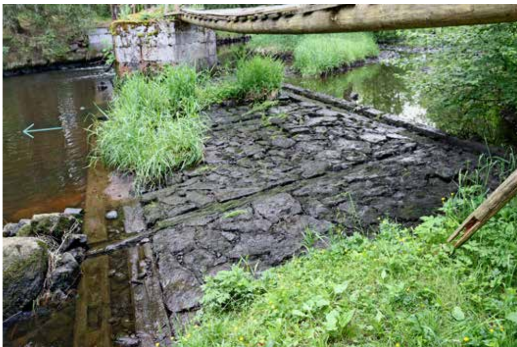
Obr. 8. Blansko u Kaplice, rechle nazývané Ponholz, zpevněné dno pod rechlemi, povodní strana, naznačený směr proudu, foto: Marie Hansová, 2024
