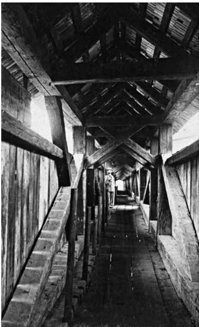
Obr. 22. Český Krumlov – Plešivec, interiér horních rechlí, pohlednice z roku 1908, v levém trámu lávky dlaby, v některých z nich vsazené tyče brlení, zdroj: SOKA Český Krumlov, album města Český Krumlov II, sign. II/G/13
