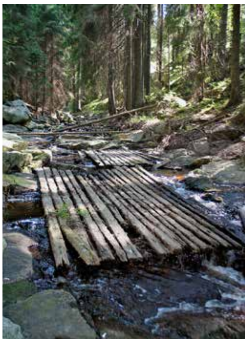
Obr. 5. Pohořský potok, dno upravené výdřevou pro potřeby plavení prámů v místech největšího spádu pod Baronovým mostem, konstrukce ve stavu porušeném povodněmi, foto: Jan Pařez, srpen 2003
