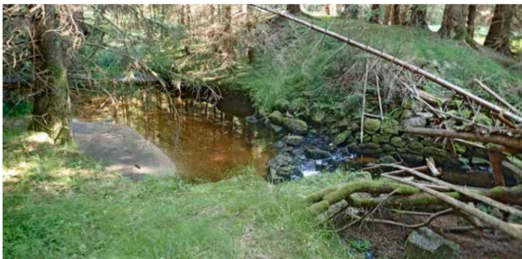
Obr. 21. Leberhartský rezervoár s propustí, respektive jezem, jeho zbytky nedaleko pod soutokem Černé a Huťského potoka, dobře zachovaná hráz, hůře zachovaná propust degradovaná zejména v posledních dvou desetiletích, po ukončení plavby dřeva kamenná konstrukce propusti využívaná v rámci občasně lesní cesty, foto: Michal Bureš, červenec 2024
