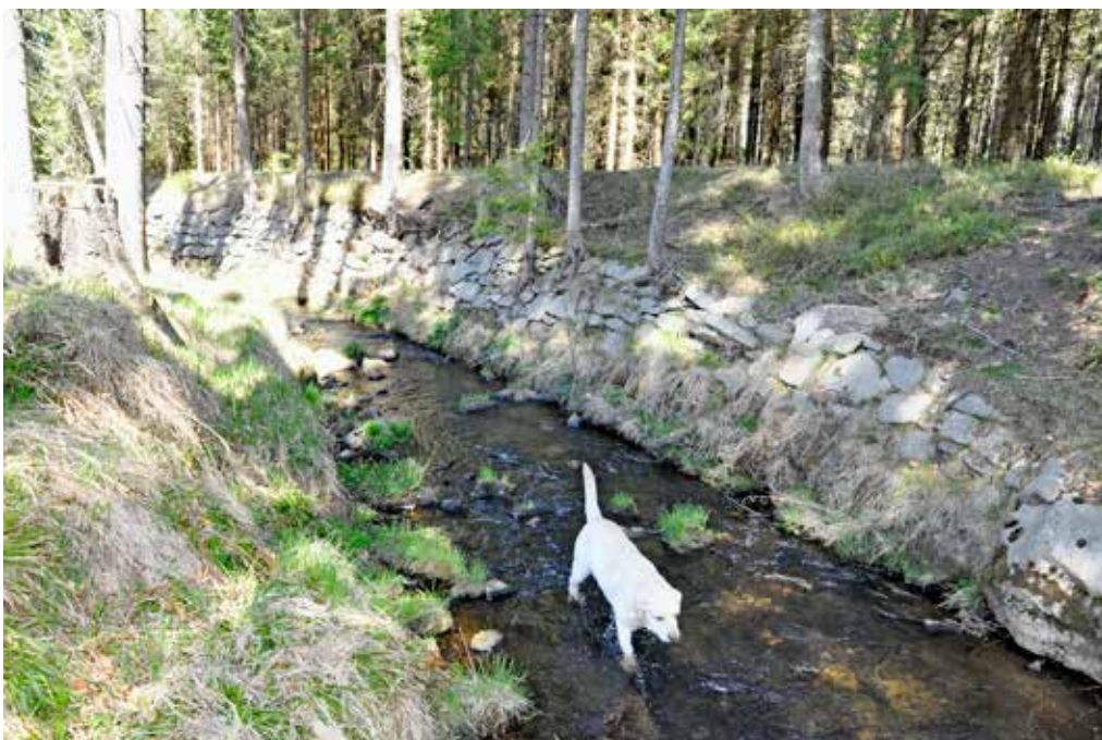
Obr. 26. Černá, taras z kamenné rovnaniny tvořené velkými nahrubo opracovanými kvádry na horním toku při cestě Žofín – Zlatá Ktiš, popudem pro stavbu tarasu byla pravděpodobně ochrana cesty před erozivním působením plavební vlny, foto: Michal Bureš, duben 2018
