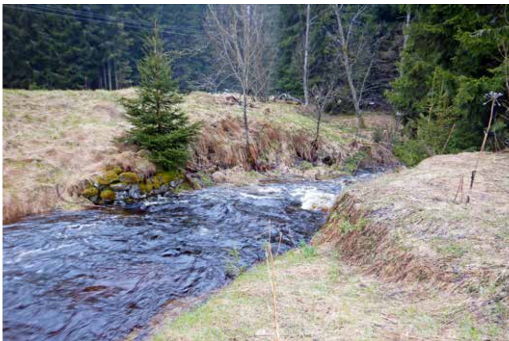
Obr. 6. Vaziště Baronův most v mělkém údolí Pohořského potoka, místo zúžení údolí před zvýšením spádu Pohořského potoka, kde byl umístěn Baronův jez (Baronwehr), dnes zachovaný v podobě torzálního zdi, foto: Michal Bureš, duben 2023
