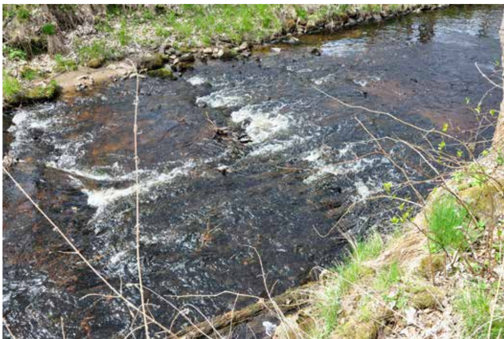
Obr. 33. Pohořský potok, Hamerský jez v Meziříčí (Uhretschläger Hammerwehr), dochovaný stupeň, pozůstatky dřevěného srubu jezu a výdřeva dna toku pod jezem, v bezprostřední blízkosti jezu zachované kamenné obestavění břehu, foto: Michal Bureš, duben 2022
