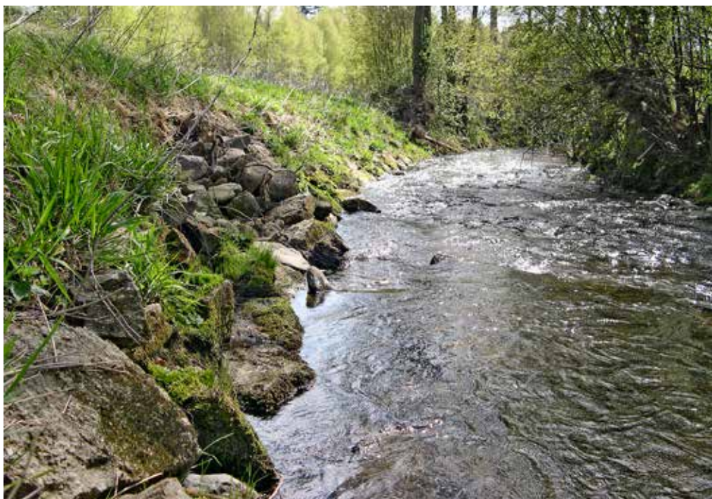
Obr. 27. Černá, umělé koryto s masivně opevněnými břehy v okolí 12. kilometru před soutokem s Pohořským potokem, foto: Michal Bureš, květen 2003
