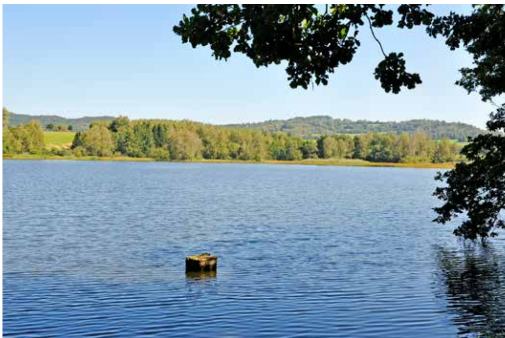
Obr. 18. Kancléřský rybník, nejstarší součást novohradské plavební soustavy, v současnosti běžný hospodářský rybník, zachována jen původní výpust bez budky se zařízením pro regulované vypouštění vody (dokumentována ještě v padesátých letech 20. století), částečně obnovený pražec, dřevěná roura vedoucí pod hrází od výpustí mělce pod hladinu vody, foto: Michal Bureš, září 2024
