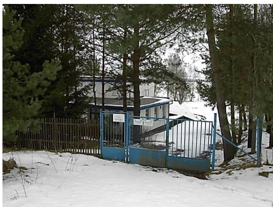
CK-1 Vodárna Cvikov
