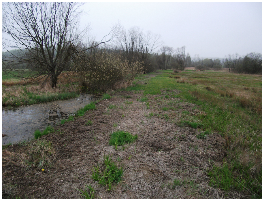
Bažantka – celkový pohled na revitalizovanou lokalitu od profilu „Strouha“ (vlevo)
