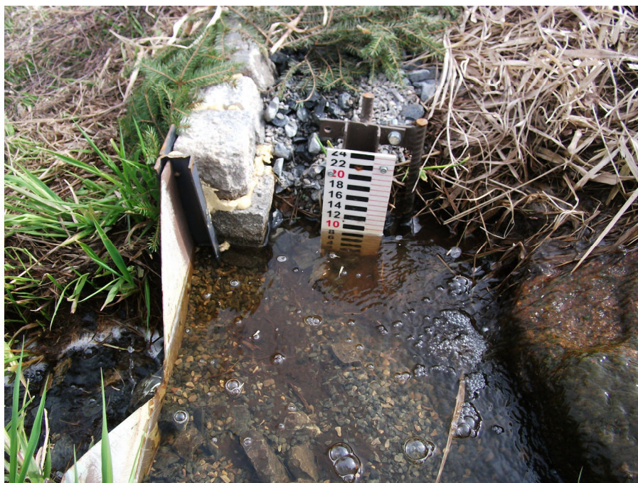
Chvojnov – detail měrného přepadu a vodočetné stanice na profilu „Vodočet“
