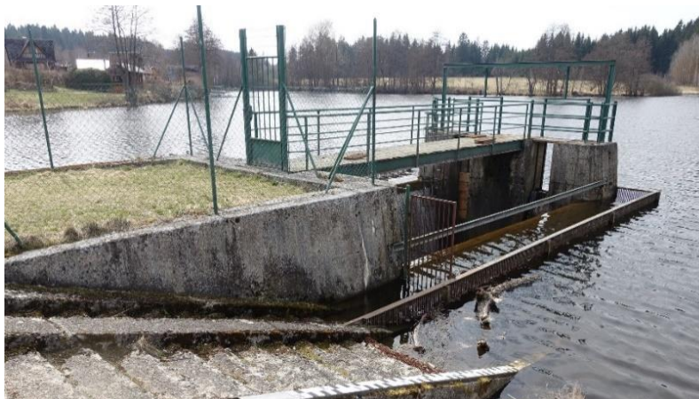
Obr. 4.6 – rybník Hejtman – sdržený objekt (bezpečnostní přeliv a spodní výpust)
