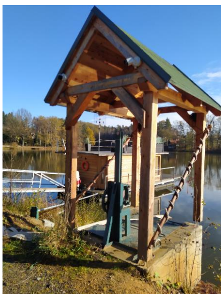
Obr. 4.3 – rybník Mrhal – vtok spodní výpusti – ovládací mechanismus (vlevo) a pohled do železobetonového třídlužového polouzavřeného požeráku s nerezovým lopatkovým uzávěrem (vpravo)
