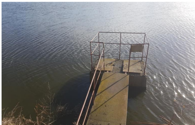
Obr. 6.12 – Funkční objekt výpust' na Nesvačilském rybníku
