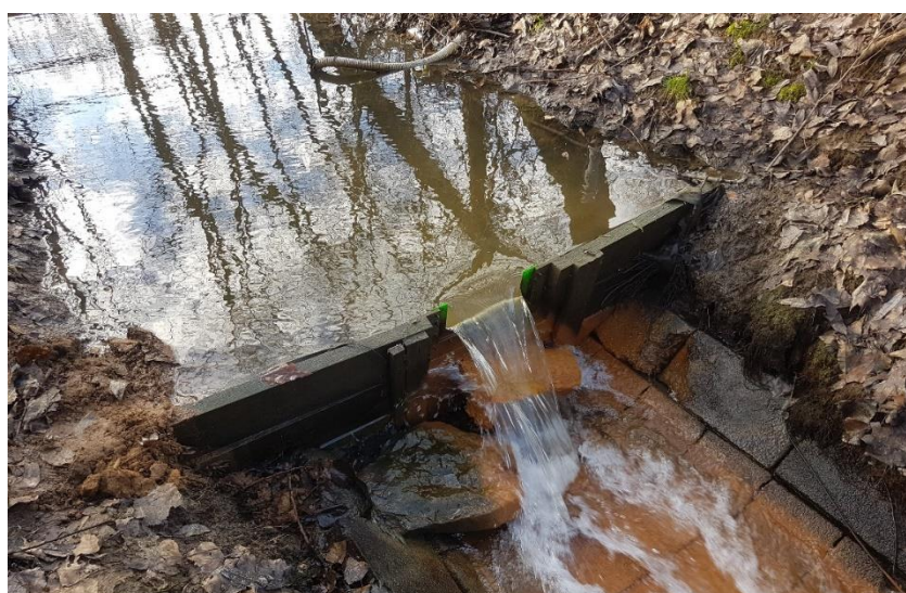
Obr. 6.8 - Vodoměrný profil s online záznamovým zařízením na přítoku do Nesvačilského rybníka – podzim 2023
