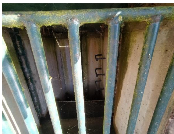
Obr. 4.3 – rybník Mrhal – vtok spodní výpusti – ovládací mechanismus (vlevo) a pohled do železobetonového třídlužového polouzavřeného požeráku s nerezovým lopatkovým uzávěrem (vpravo)
