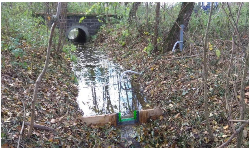
Obr. 6.6 - Vodoměrný profil s online záznamovým zařízením na přítoku do Nesvačilského rybníka – podzim 2021
