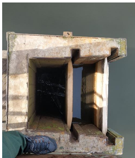
Obr. 4.4 – Hubenovský rybník – vtok spodní výpusti – požerák (vlevo) a pohled do požeráku (vpravo)
