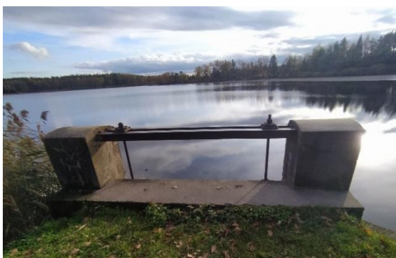
Obr. 4.8 – Nový lipnický rybník – vtok spodní výpusti – ovládací mechanismus (vlevo) a pohled na uzávěr (vpravo)
