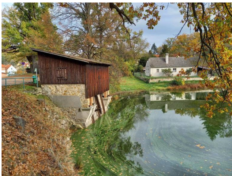
Obr. 4.5 – Staňkovský rybník – manipulační domek s ovládacím mechanismem dřevěných stavidlových uzávěrů (lopat) na vtoku do spodní výpusti
