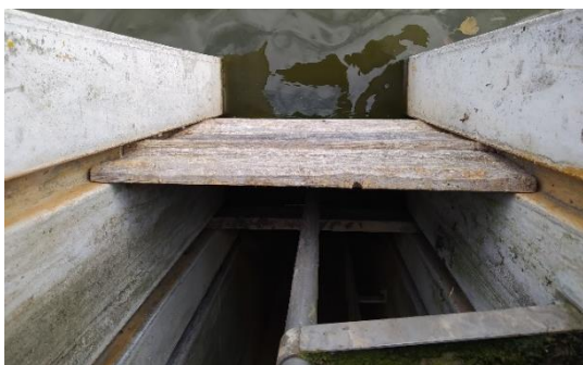
Obr. 4.7 – Ovčácký rybník – vtok sodní výpusti – železobetonový požerák s dlužemi a šoupětem pro rychlé vypuštění (nahore), detail dluží (vlevo) a pohled do šachty požeráku (vpravo)
