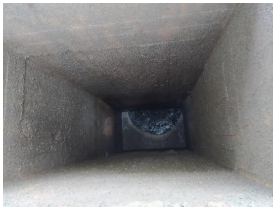
Obr. 4.9 – Podkostelní rybník – vtok do výpusti – pohled na požerák (vlevo) a do šachty požeráku (vpravo)
