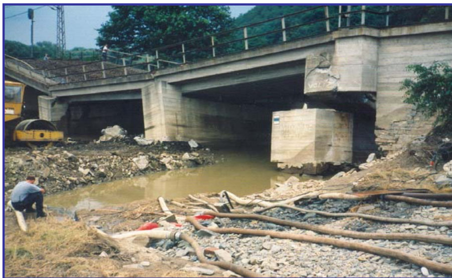
Zřícený inundační most v Moravičanech na řece Moravě za povodně v roce 1997
