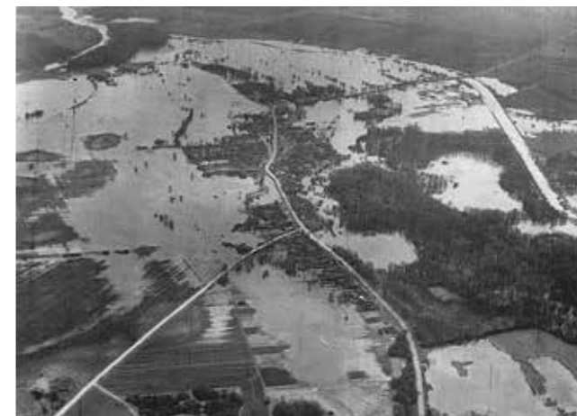
Obr. 4.12.6 Letecký snímek povodní ze severozápadního směru (Povodí Moravy, s.p.)
