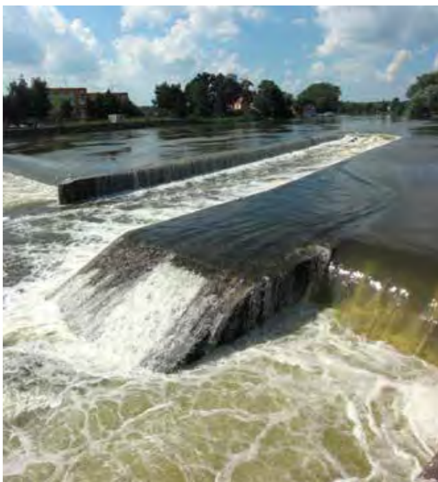
Obr. 4.6.9 Za povodňových průtoků mizí rybí přechod v Břec-lavi pod vodní hladinou (D. Veselý, 2015)
