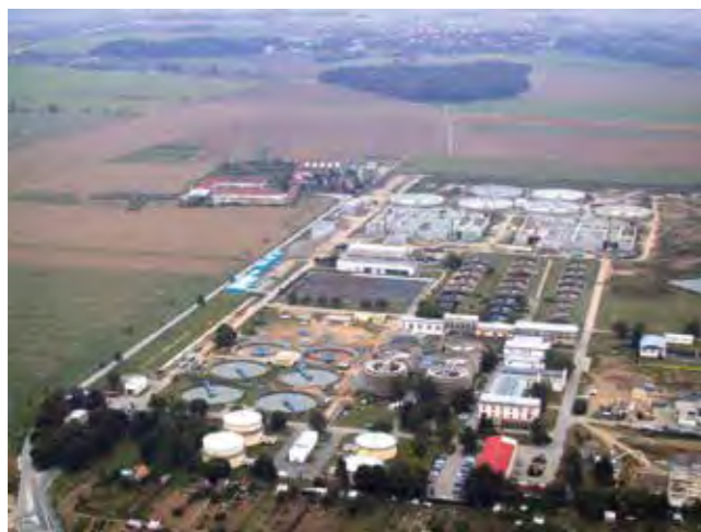
Obr. 1.3.6 Čistírna odpadních vod v Brně-Modřičích, 2002 (Brněnské vodárny a kanalizace, a.s.)
