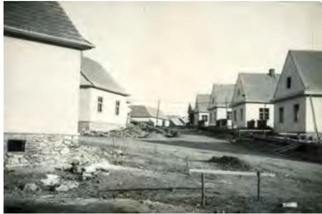
Obr. 2.4.10 Výstavba nového Bítova (MZA v Brně, G 124, kn. 1)
