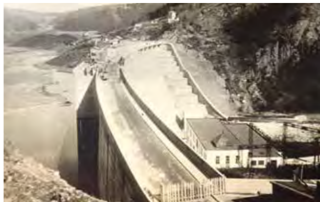
Obr. 2.1.6 Dokončená hráz Vranovské přehrady – pohled na kaskádu tlumící přechod povodňových průtoků, 1933 (Povodí Moravy, s.p., Znojmo)
