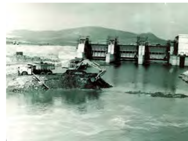
Obr. 4.1.4 Stavba dolní novomlýnské nádrže, 1987 (Povodí Moravy, s.p.)
