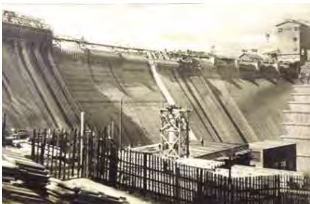
Obr. 2.1.1 Hráz Vranovské přehrady před dokončením (Povodí Moravy, s.p., Znojmo)
