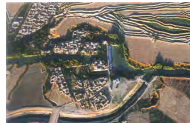
Obr. 1.2.2 Emírova přehrada (Band-e Amir) byla vybudována v roce 980 na místě ještě starší nádrže. Slouží k zavlažování oblastí Marv Dacht v Íránu (převzato z J. Němce, 2016)
