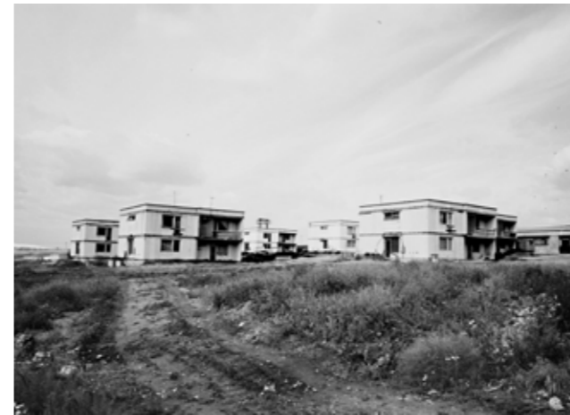
Obr. 4.5.13 Výstavba bungalovů určených nejprve stavebním dělníkům a později přeměněných na ubytování rekreatantů nedaleko hráze mezi I. a II. stavbou. 1976 (Regionální muzeum v Mikulově)
