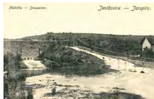
Obr. 1.2.1 Nádrž Jevišovice na dobových pohlednicích (na spodní si můžeme všimnout hrázného sledujícího průchodu povodně) (archiv autora: D. Veselý)
