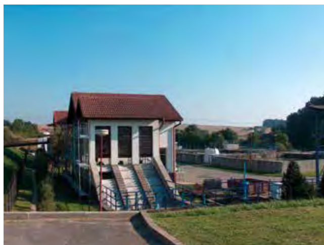
Obr. 1.3.7 Čistírna odpadních vod ve Velké Bíteši (S. Jurář, 2010)
