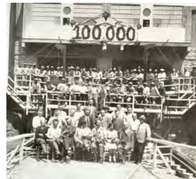
Obr. 2.1.5 Spotřebováno 100 000 m 3 betonu, 21.5.1932 (Povodí Moravy, s.p., Znojmo)
