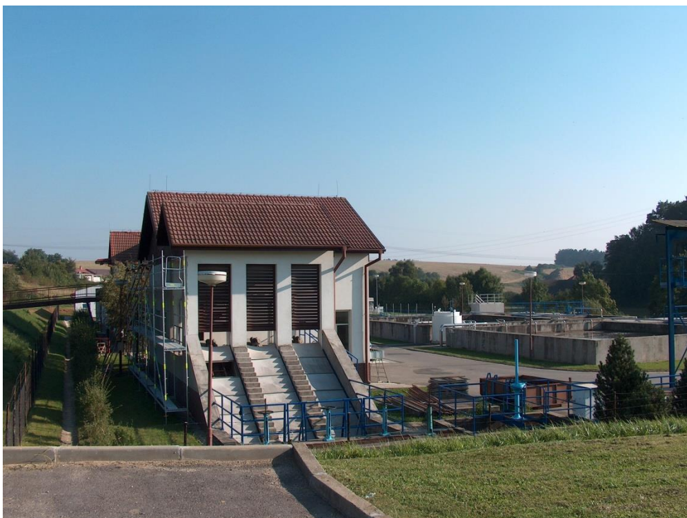
Obr. 26.6 Čistírna odpadních vod ve Velké Bíteši
