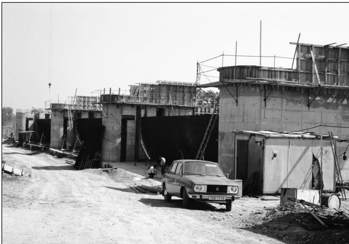
Obr. 28.5: Stavba VD NM
