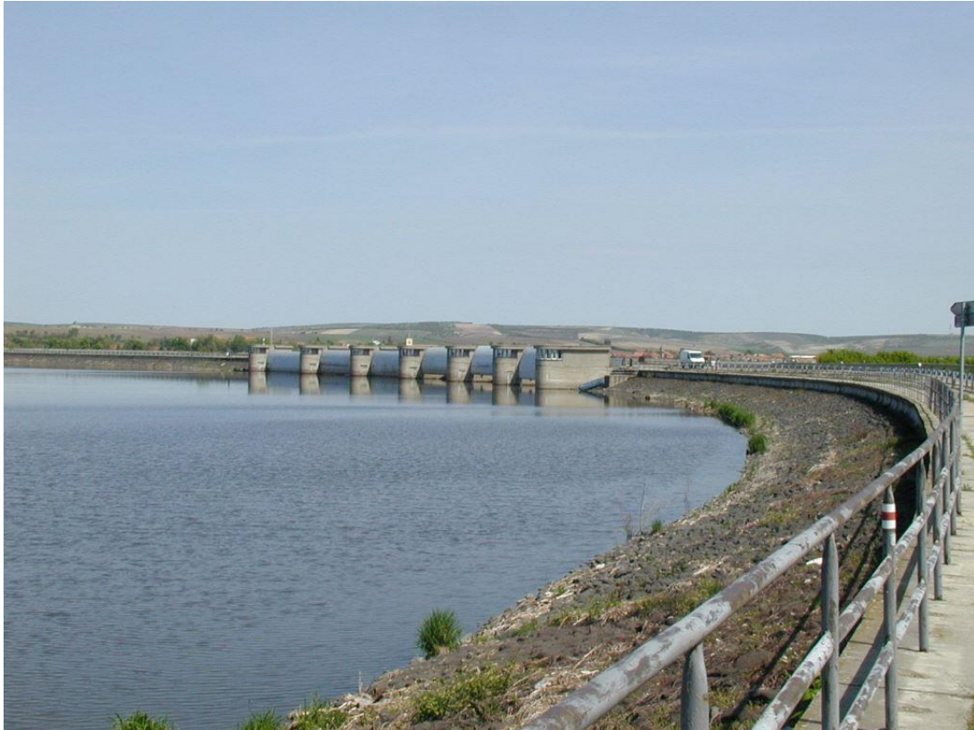
Obr. 28.6: Hráz mezi horní a střední nádrží VD Nové Mlýny, 2003
