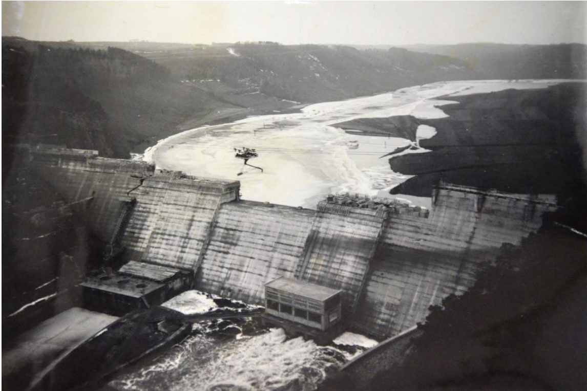
Obr. 28.8: Stavba hráze Vranovské přehrady, pohled do dnes zatopeného údolí
